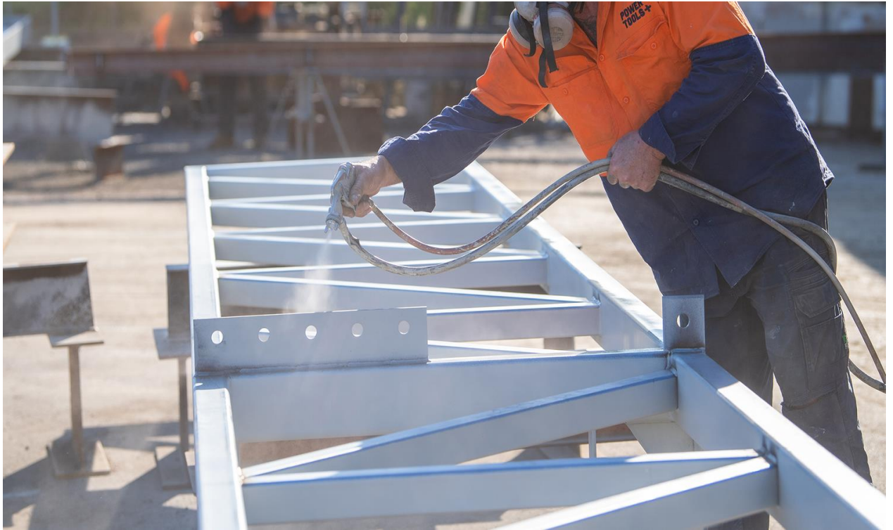
Figura 5.11 Pintura de estructura metálica
