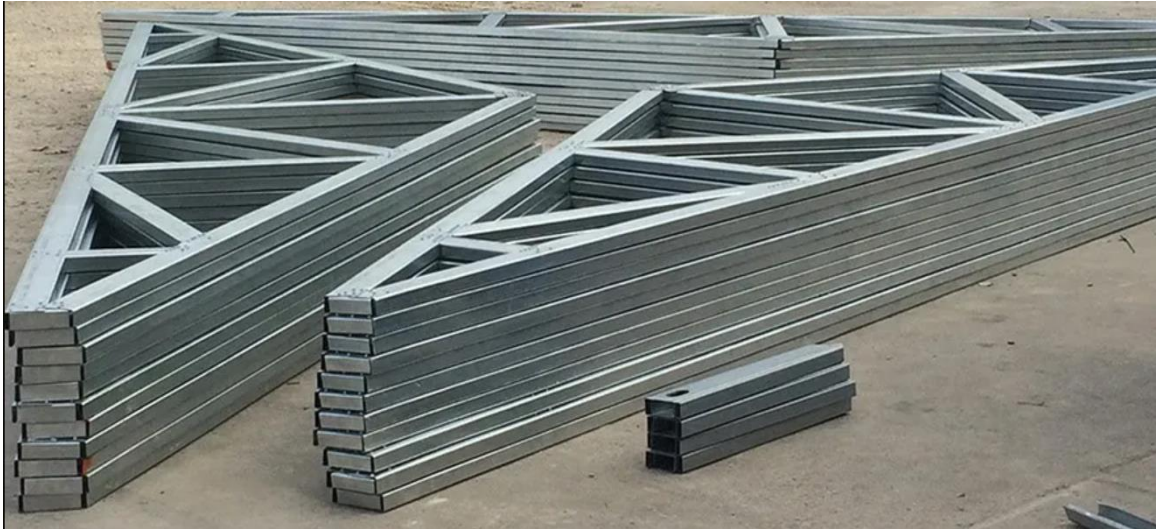
Figura 5.9 Armado de estructuras
