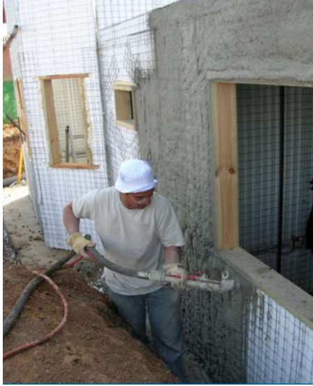
Ilustración 50. Aplicación del mortero lanzado - Emmedue, 2008.
