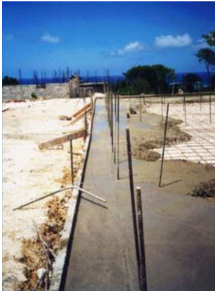
Ilustración 41. Refuerzo vertical saliente para amarre con panel - Emmedue, 2008.
