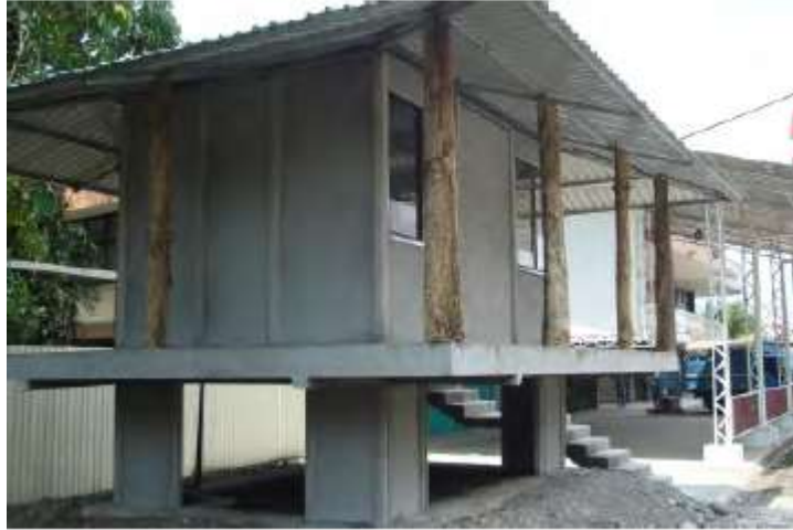
Ilustración 58. Construcción elevada en sistema Prefa PC - Prefa PC, 2021.
