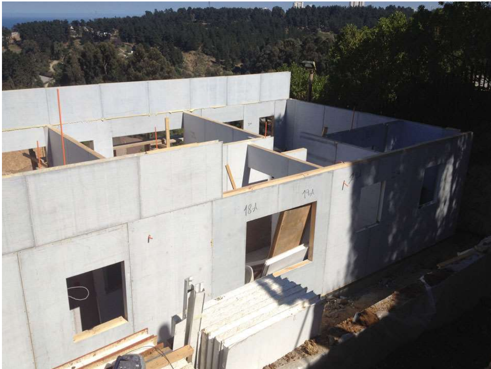
Ilustración 12. Sistema Estructural de Panel Insulado (SIP)
