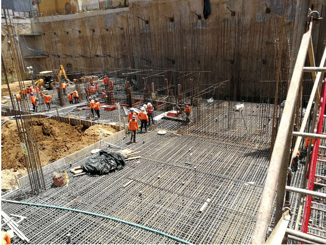
Ilustración 20. Losa de Cimentación - Elaboración propia, 2018.
