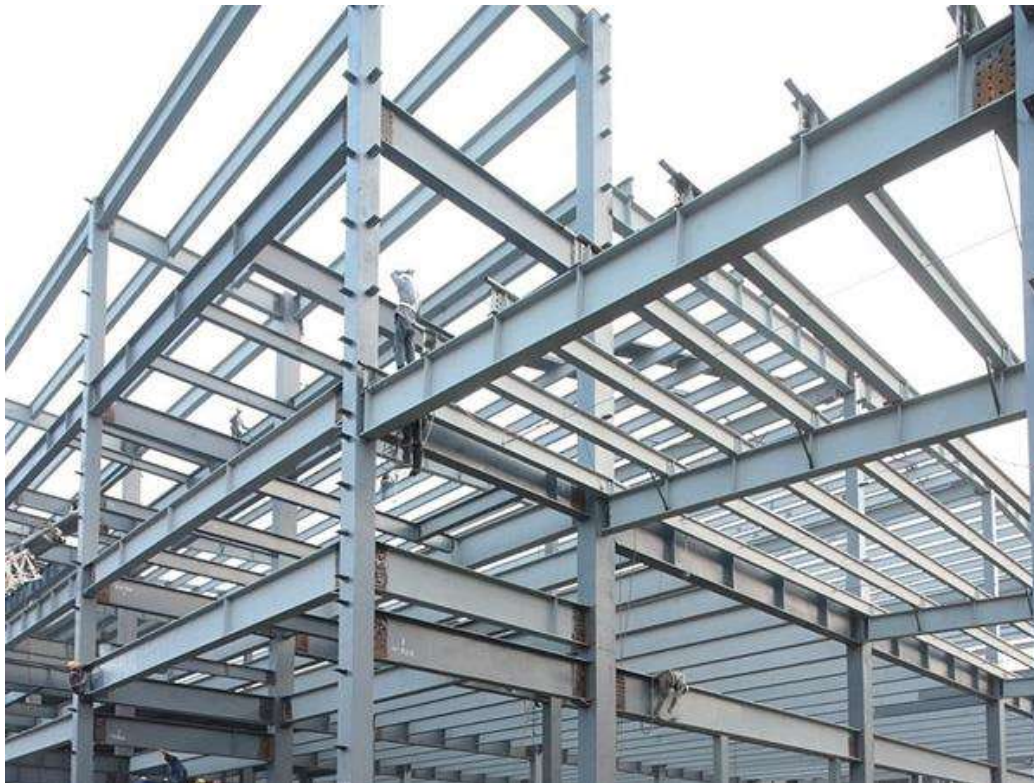
Ilustración 8. Sistema en Acero tipo Marco Rígido - Desconocido
