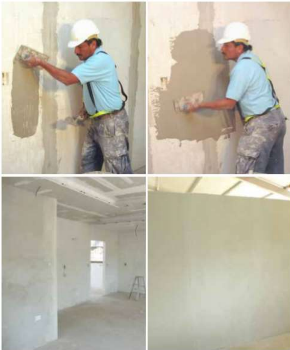
Ilustración 37. Aplicación de "base coat" posterior al tratamiento de juntas - Panacor.
