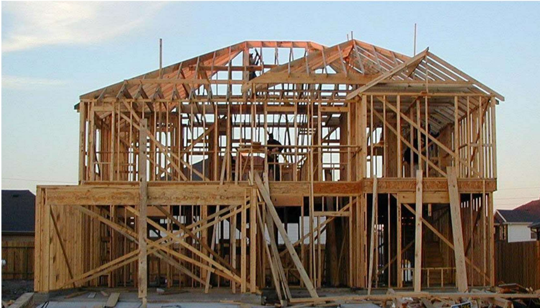
Ilustración 7. Sistema de Estructura de Madera - Desconocido.
