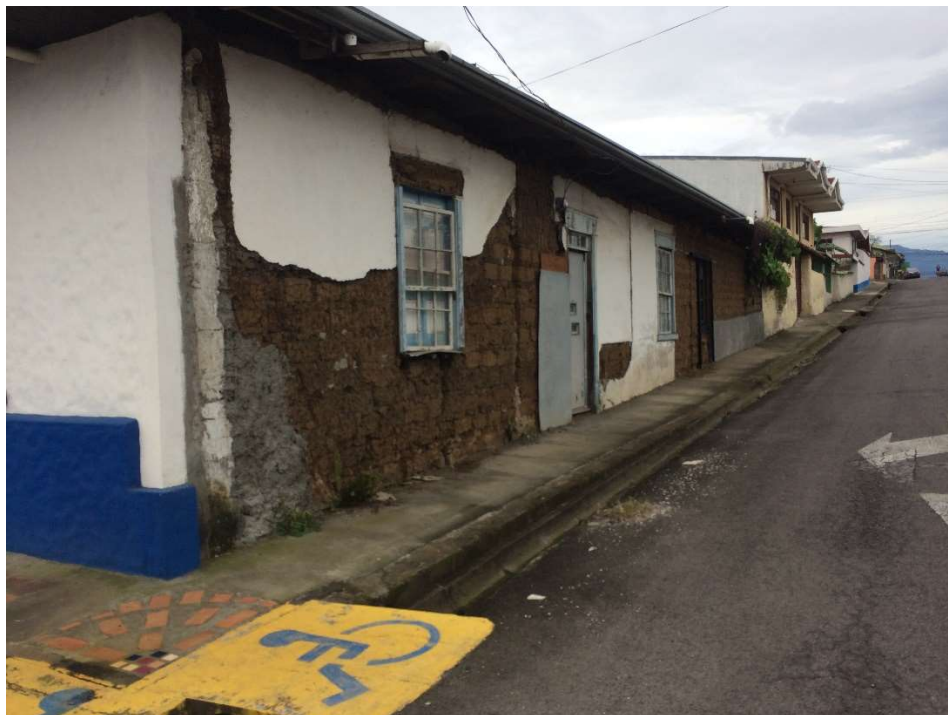
Ilustración 5. Sistema constructivo en adobe - Cartín, 2018.
