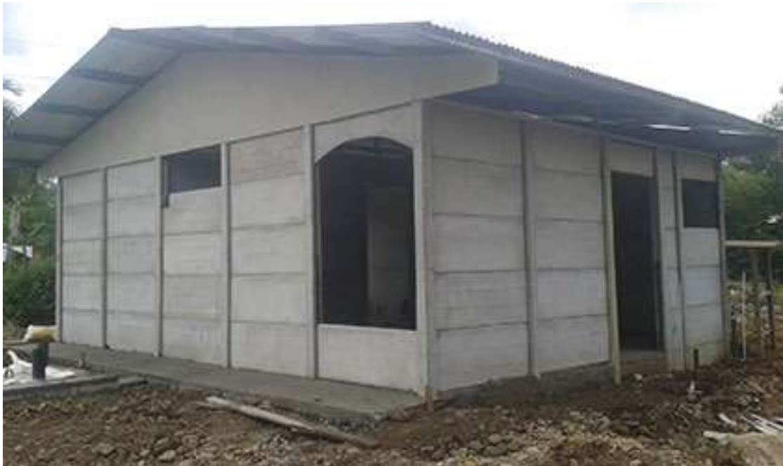
Ilustración 52. Casa en sistema prefabricado de columnas y baldosas horizontales - PrefaCR, 2021.
