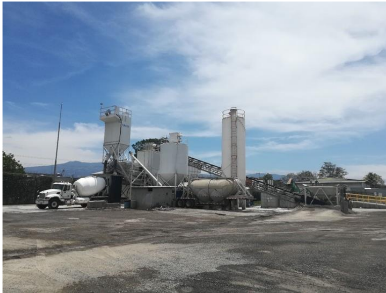
Ilustración 8. Planta de concreto premezclado
