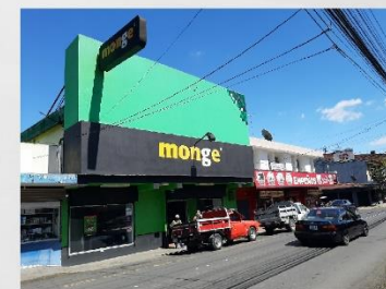
Edificio comercial dos niveles
