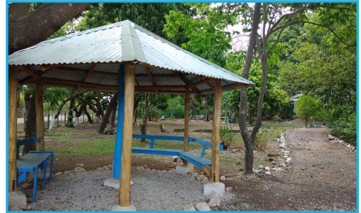
Fotografía 58. Segundo quiosco en el acceso del Telecolegio de Ostional.
