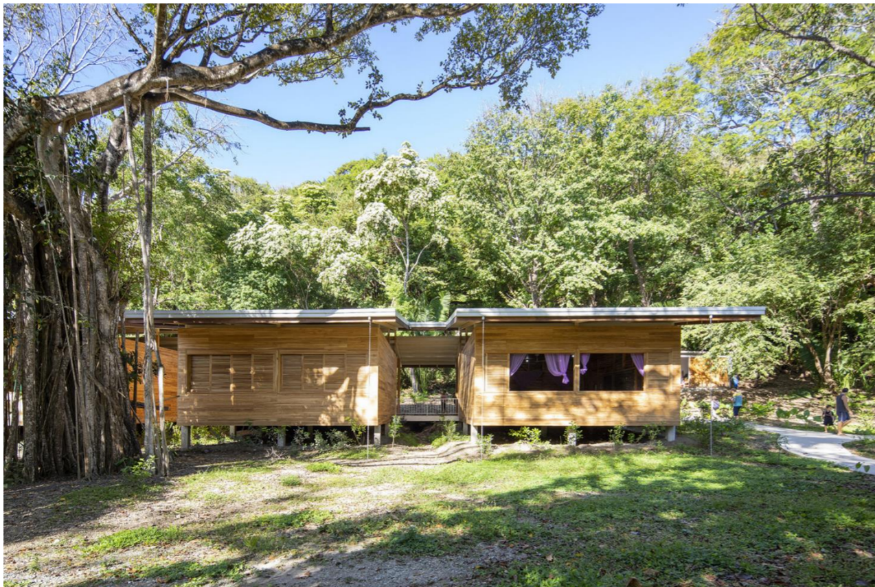
Fotografía 1. Fachada posterior de Escuela Waldorf
