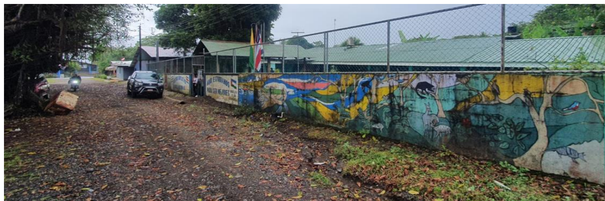
Fotografía 37. Vista del mural de la Escuela de Ostional
