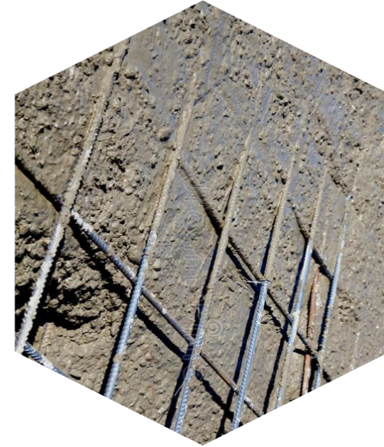
Fotografía 81. Materialidad: contrapiso de concreto armado Fotografía por Universidad Central del Ecuador
