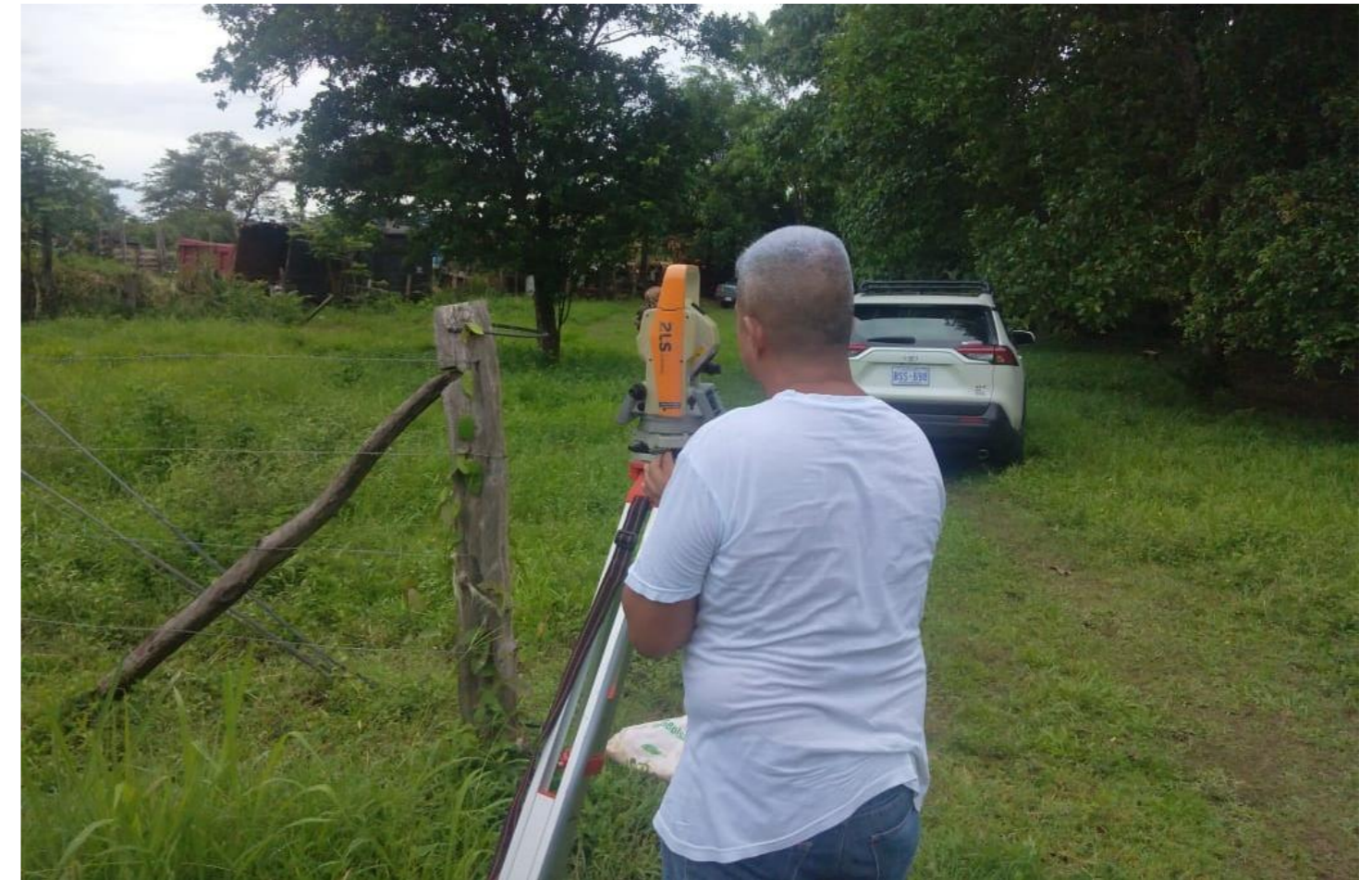
Fotografía 72. Toma de las curvas de nivel en campo.
