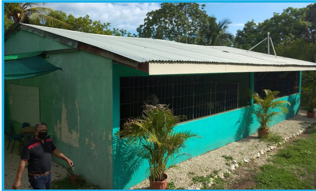
Fotografía 60. Vista externa de las aulas del Telecolegio de Ostional
