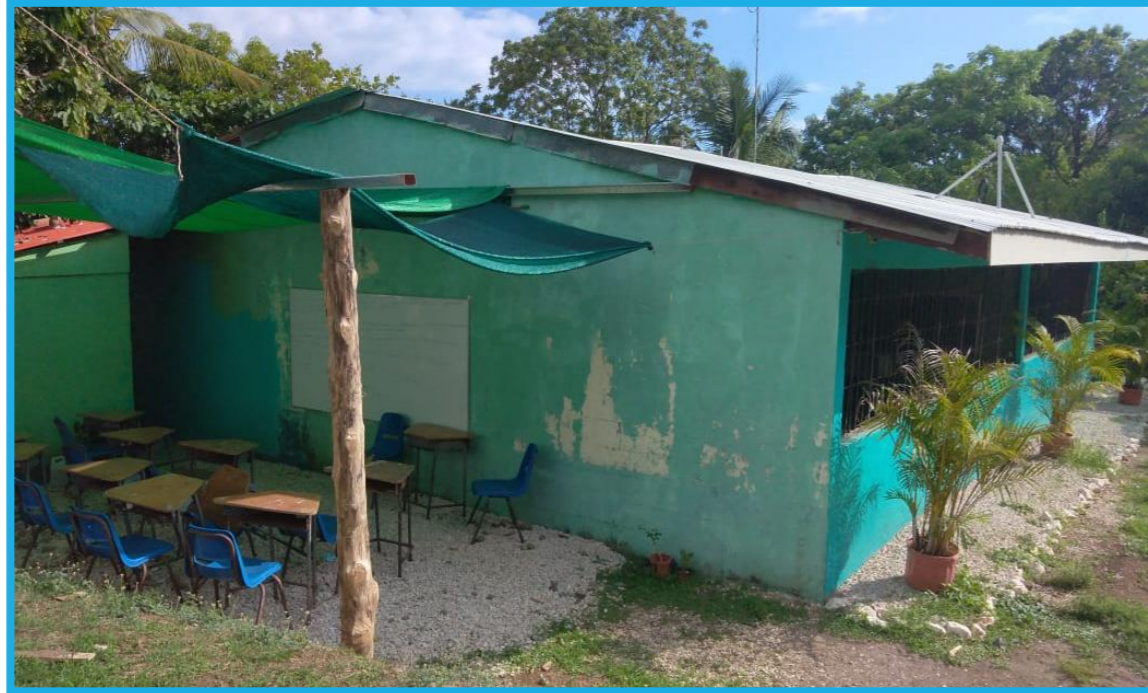
Fotografía 64. Vista externa de aula improvisada.
