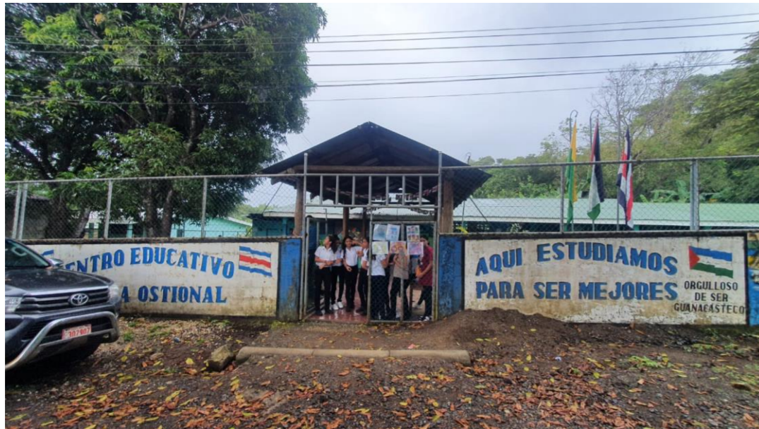
Fotografía. 36 Escuela de Ostional
