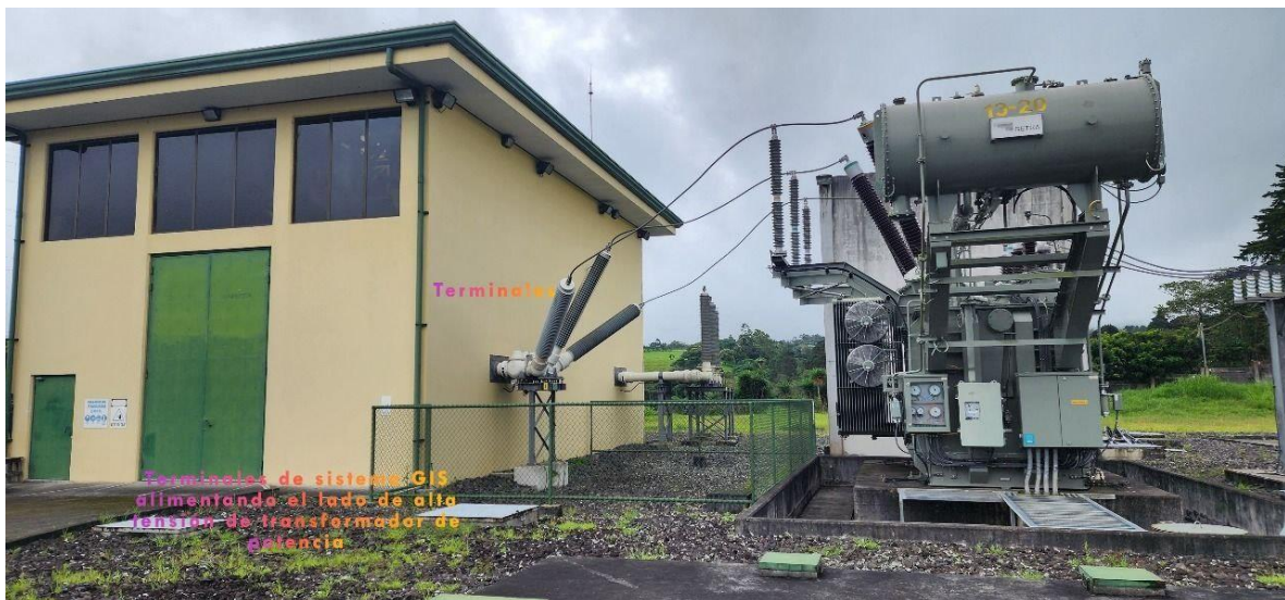
Figura 10.. Salida del secundario del transformador. Fuente: CNFL
