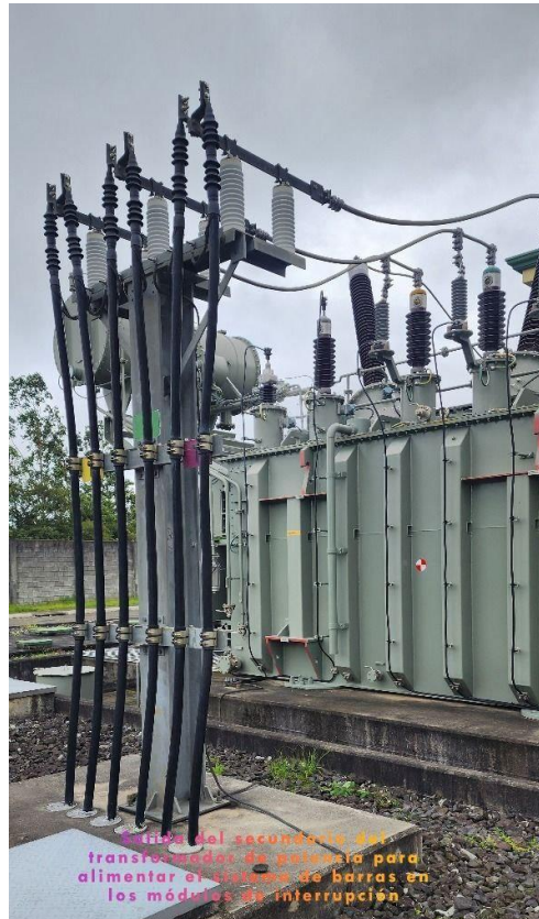
Figura 10.. Salida del secundario del transformador. Fuente: CNFL
