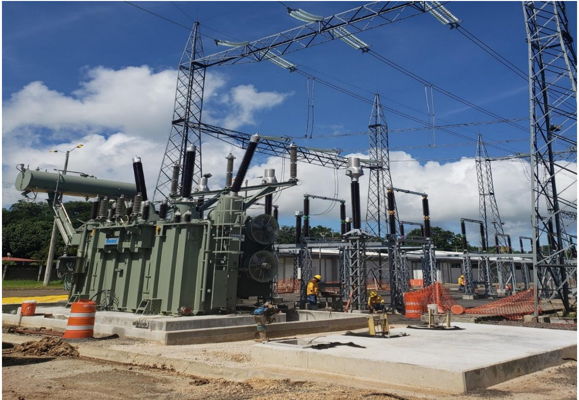
Figura 16. Cimiento, pileta y tanque recolector. Fuente: ICE
