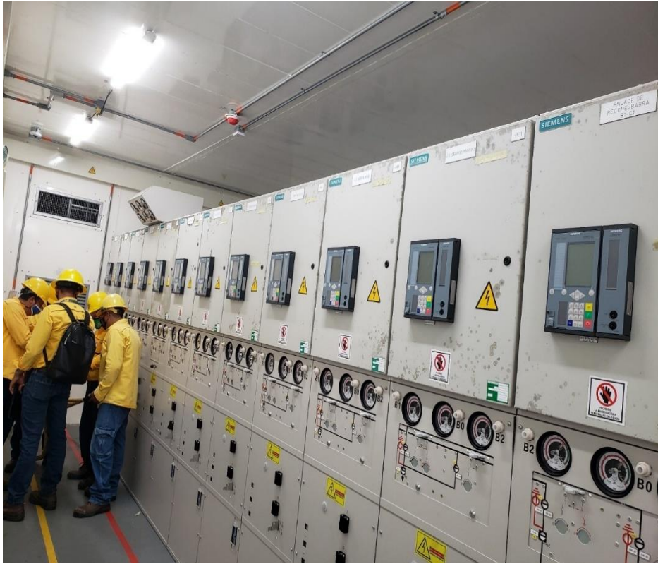
Figura 8. Equipo MT tipo GIS. Fuente: ICE
