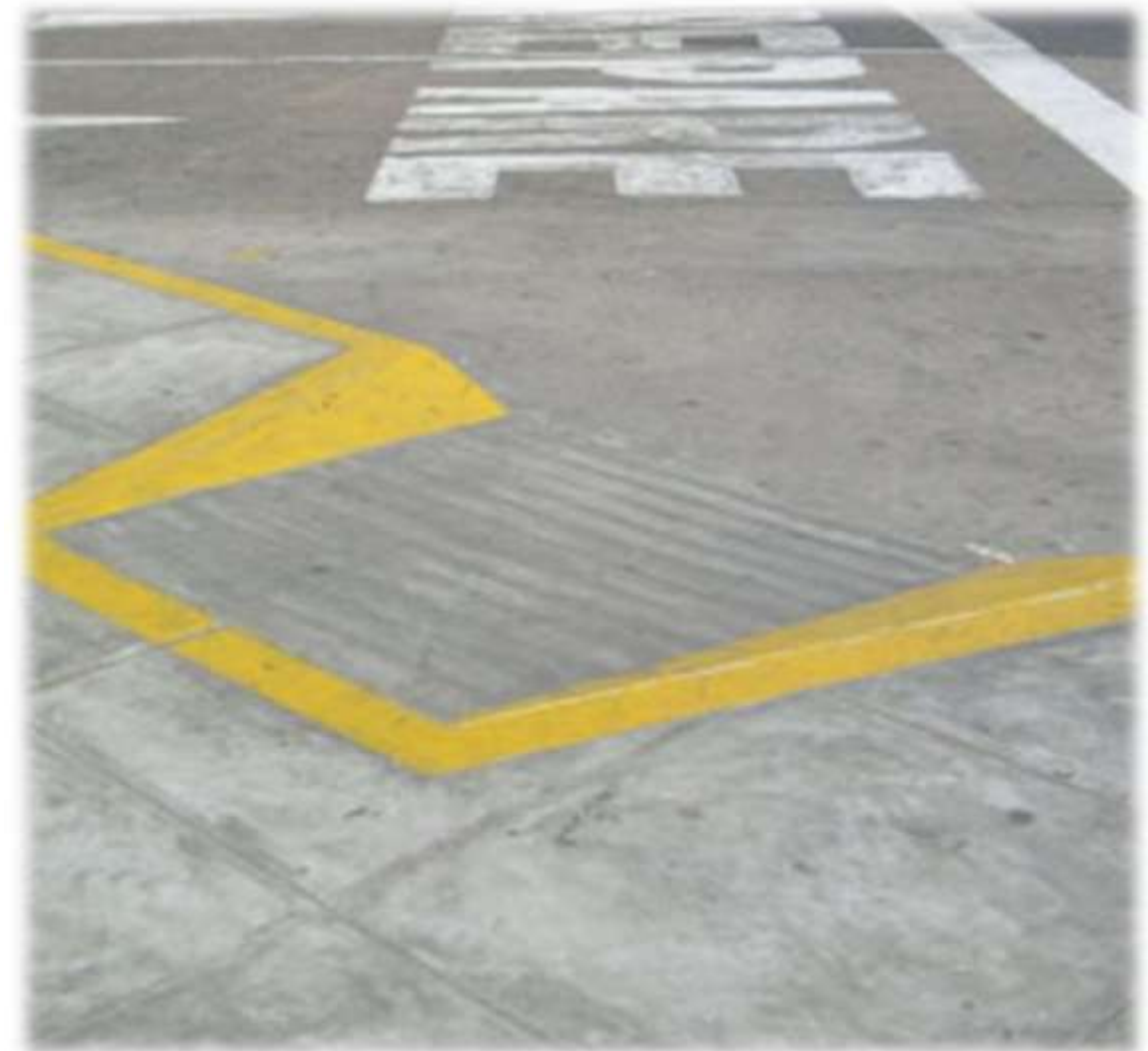
Figura 43 Rampa en aceras
