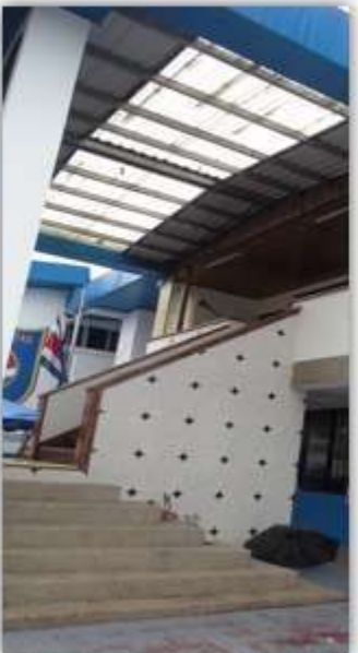
Gradas de acceso 2do piso
