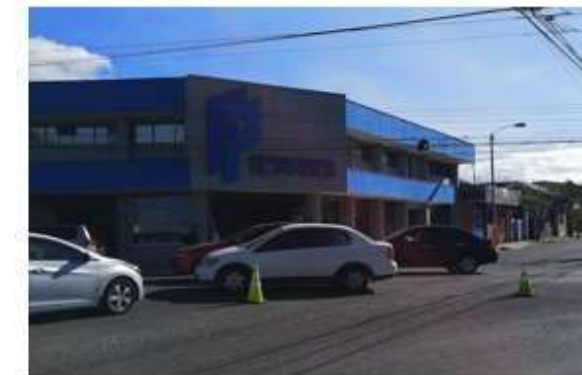
6. Intersección Avenida 22, Calle 13
