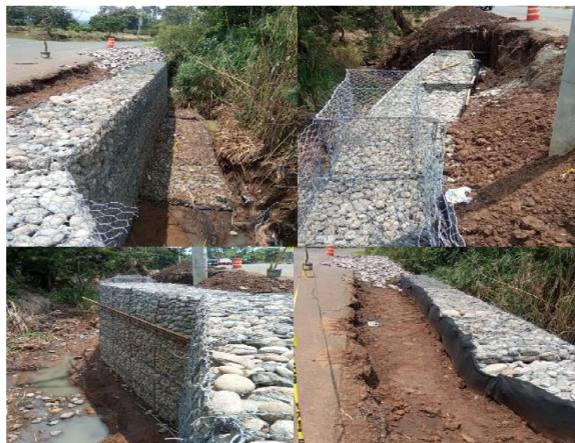
Imagen # 24. Visita de campo a proyecto en Santo Domingo construcción muro de gaviones Fuente: propia, 2022
