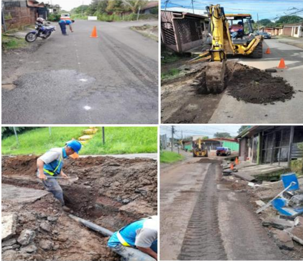
Imagen # 10. Trabajos de localización, excavación y sustitución de tubería Asada San Pedro de Barva Fuente: Propia, 2022
