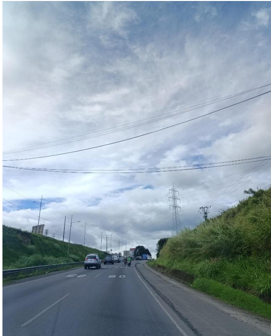
Figura 1: Ubicación de la torre y la Ruta Nacional N°2 Fuente: Autor
