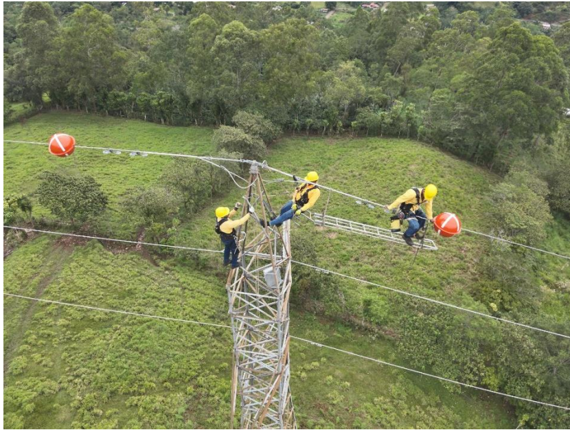
Figura 6: Técnicos Líneas Transmisión (Huetar Brunca), Grupo ICE. Fuente: Autor
