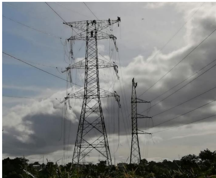
Figura 44: Maniobras de tensado de conductor (flechado)
