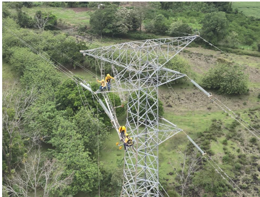
Figura 7: Técnicos Líneas Transmisión (Huetar Brunca), Grupo ICE. Fuente: Autor
