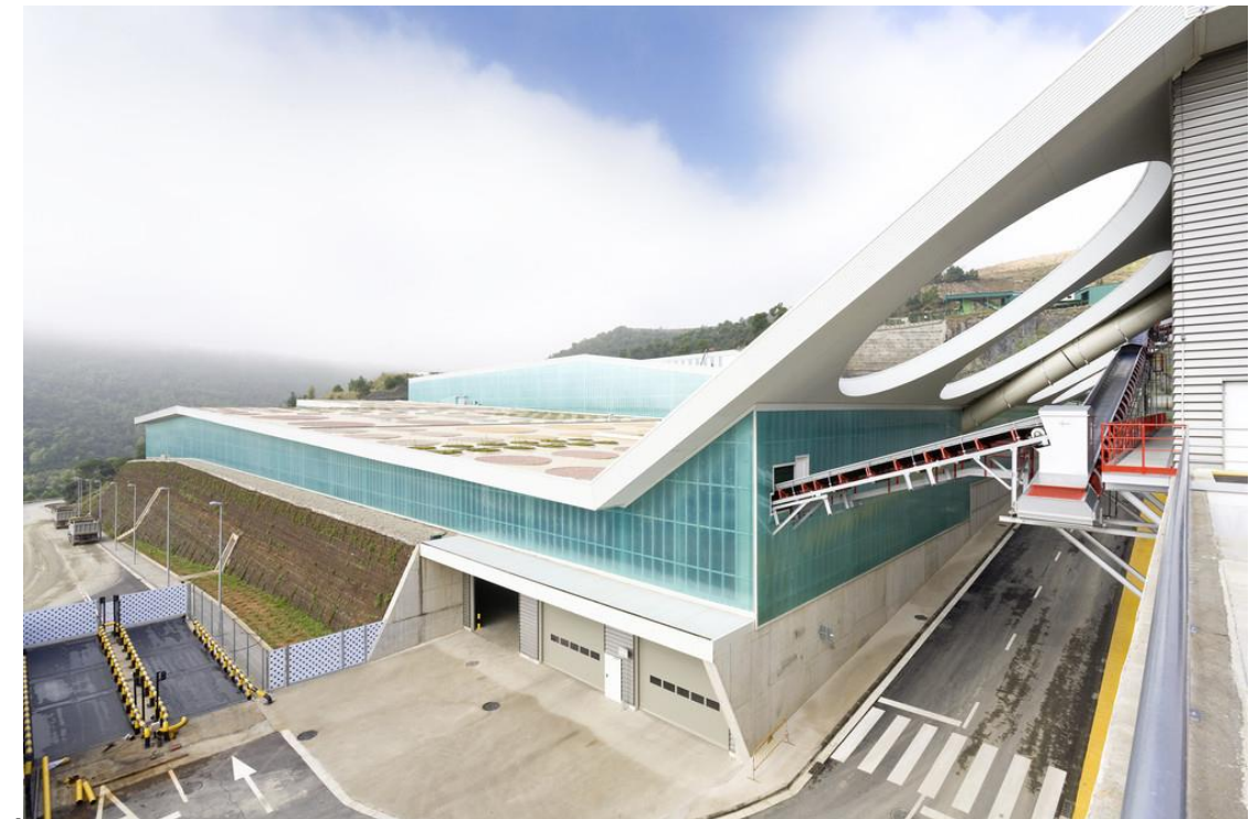
Figura 36. Vista de la Planta.
