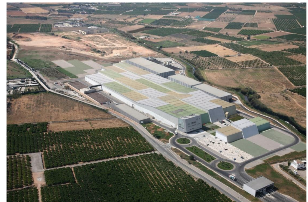
Figura 44. Vista general de la planta.
