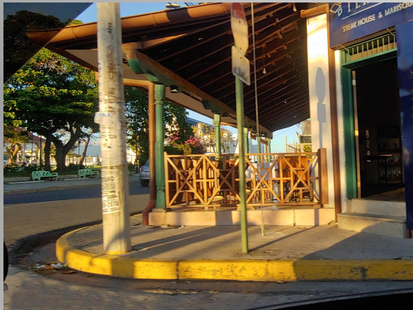
Ilustración 40. Ausencia de rampa ley 7600, alrededores parque Mario Cañas Ruiz
