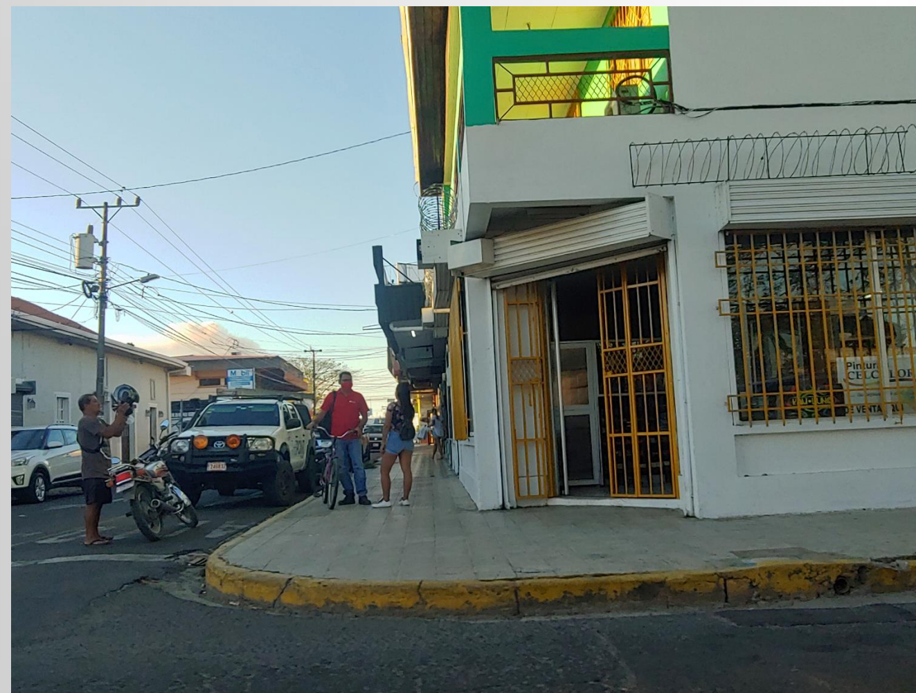
Ilustración 45. Ausencia rampa ley 7600, Liberia centro
