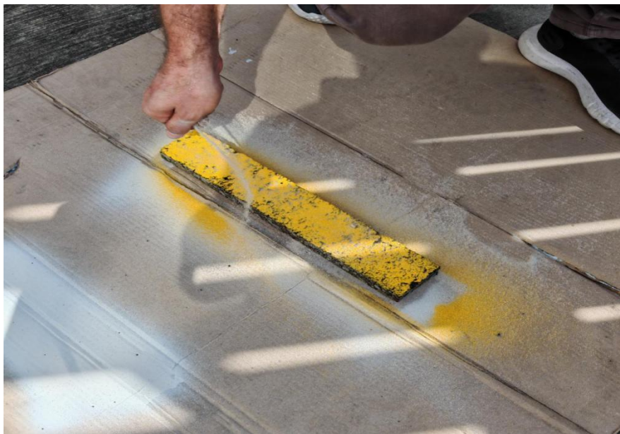
Fig. 37. Aplicación de microsferas. Fuente: Propia
