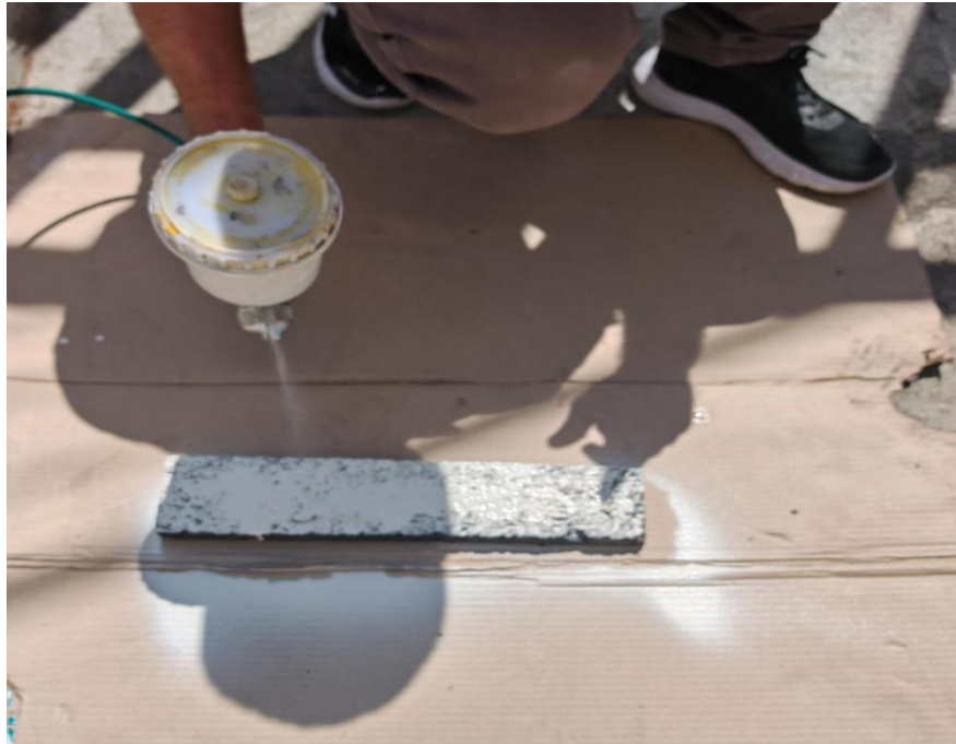
Fig. 34. Aplicación de pintura blanca. Fuente: Propia
