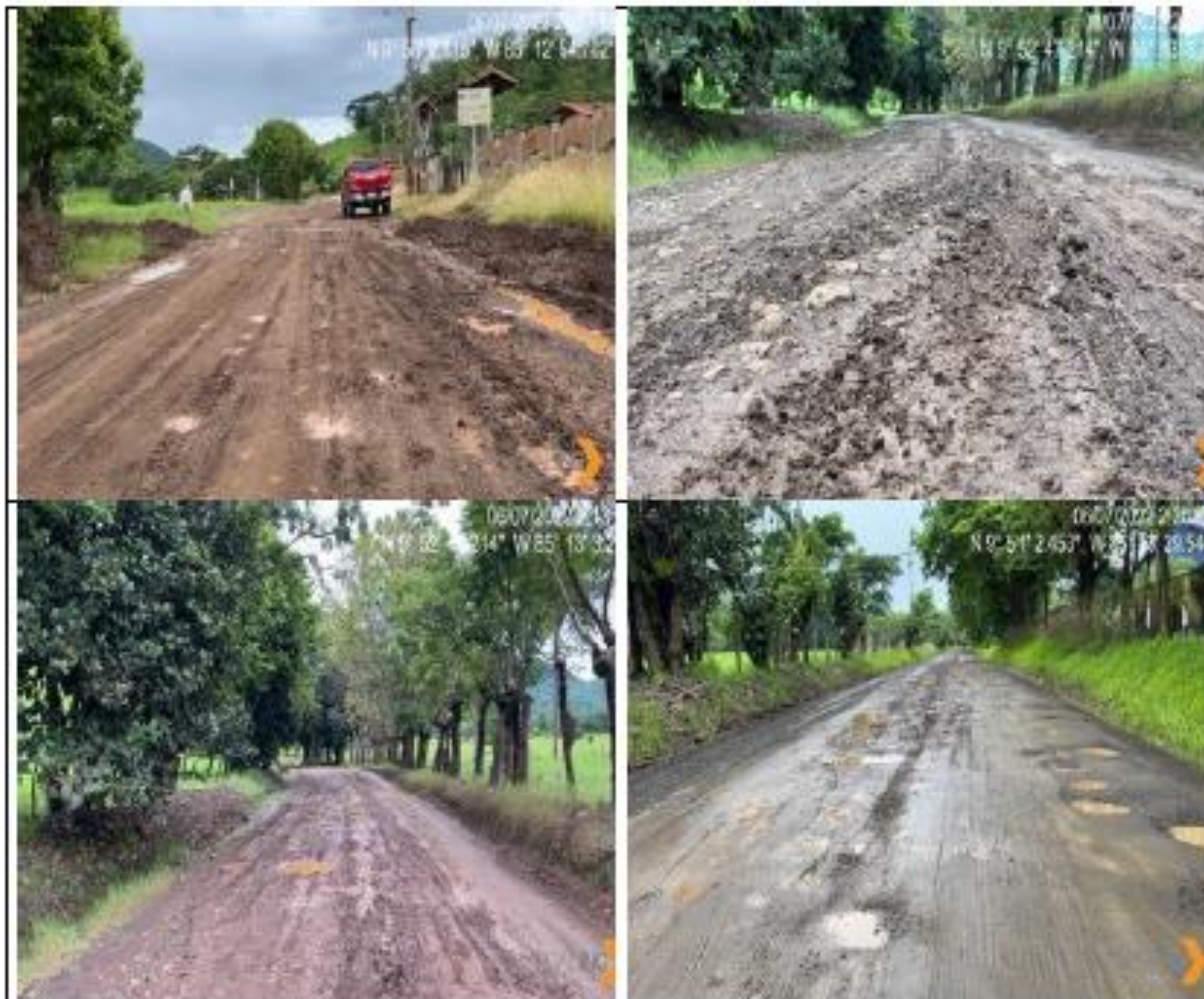
REGISTRO FOTOGRAFICO DEL ESTADO SUPERFICIAL RUTA NACIONAL 160 SAN FRANCISCO DE COYOTE A PUNTA ISLITA.
