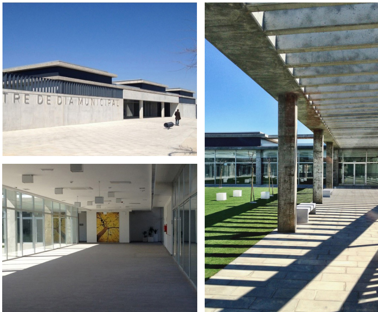
Figura 14: Residencia L'Onada Vinaros. Fuente: https://www.archdaily.com.br/ .
