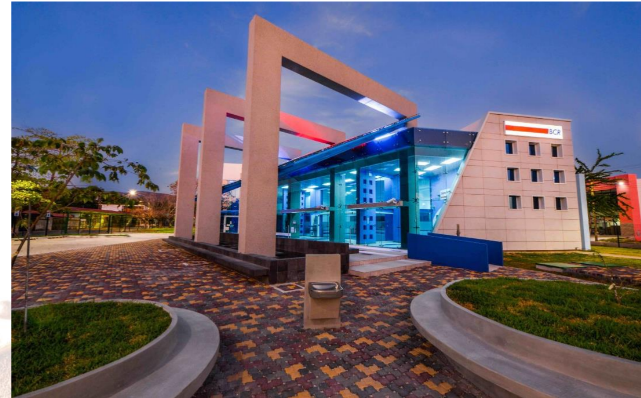
Ilustración 68 Centro de negocios del Banco de Costa Rica en Nicoya, primera edificación con certificación LEED Platinum en Costa Rica, fuente: Diario ELMundoCR, 2016
