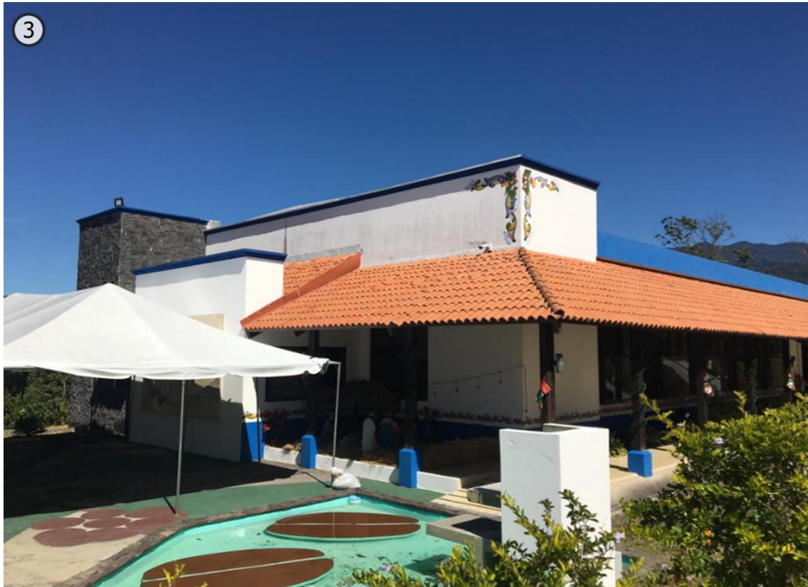
Ilustración 143 Edificio administrativo del ICAFE, fuente: autor, 2021
