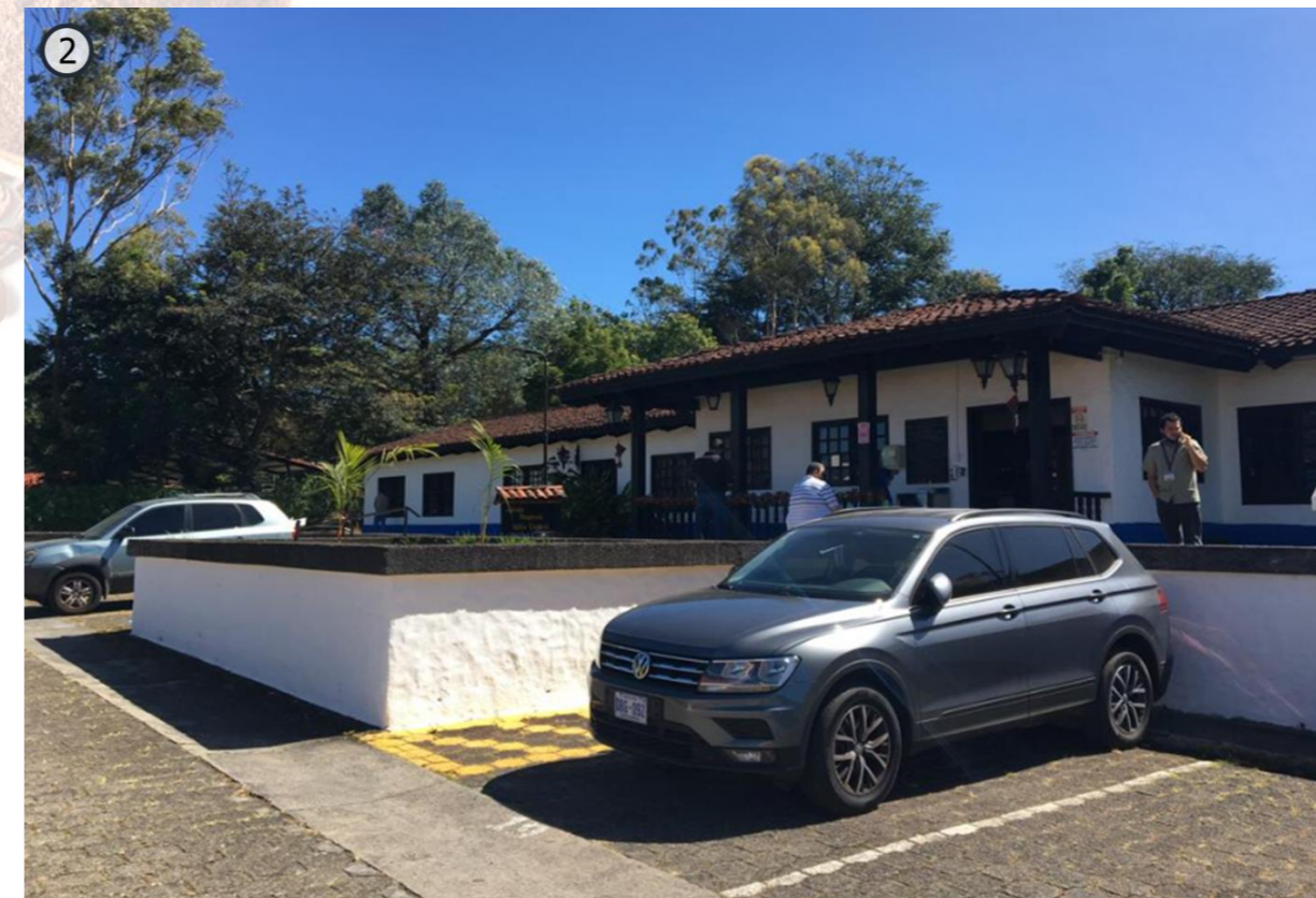
Ilustración 142 Edificio de la Gerencia Técnica del ICAFE, fuente: autor, 2021
