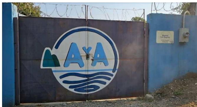
Figura 2.12: Entrada Booster Los Angeles.
