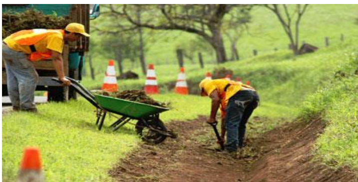
Imagen 5. Limpieza de cunetas y canales revestidos de manera manual.
