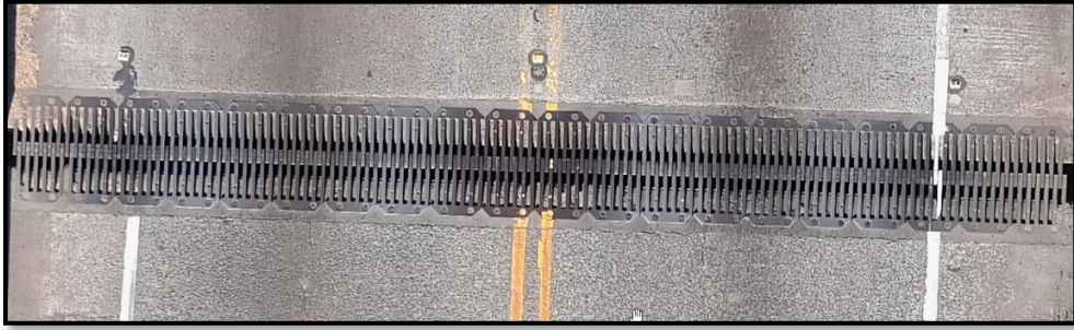
Imagen 38. Fotografía F_ Puente sobre el río Concepción
