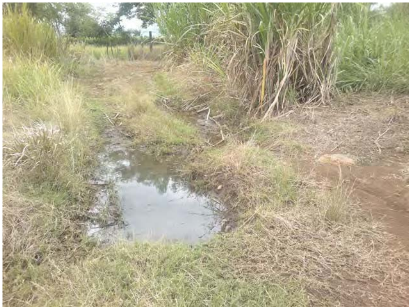
Imagen 34. Agua encharcada por baja permeabilidad del terreno (suelos tipo D)
