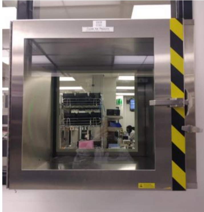
Figura 4.14: Caja de intercambio
