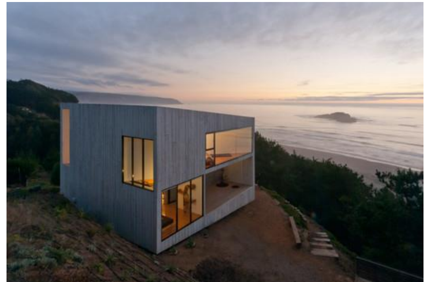
Ilustración 56: Casa de habitación de concreto armado en ambiente costero.
