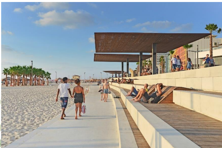
Ilustración 7: Tramo de rampas y gradas.
