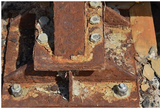
Ilustración 46: Corrosión generalizada.
