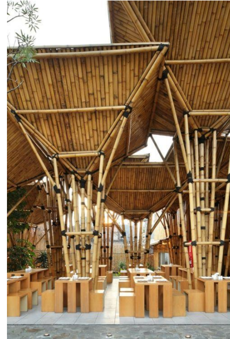
Ilustración 60: Estructuras con bambú.
