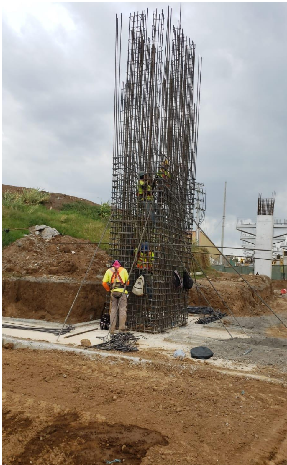
5.4.11 Imagen 11, Ampliación paso Firestone, armado de columna, autoría propia
