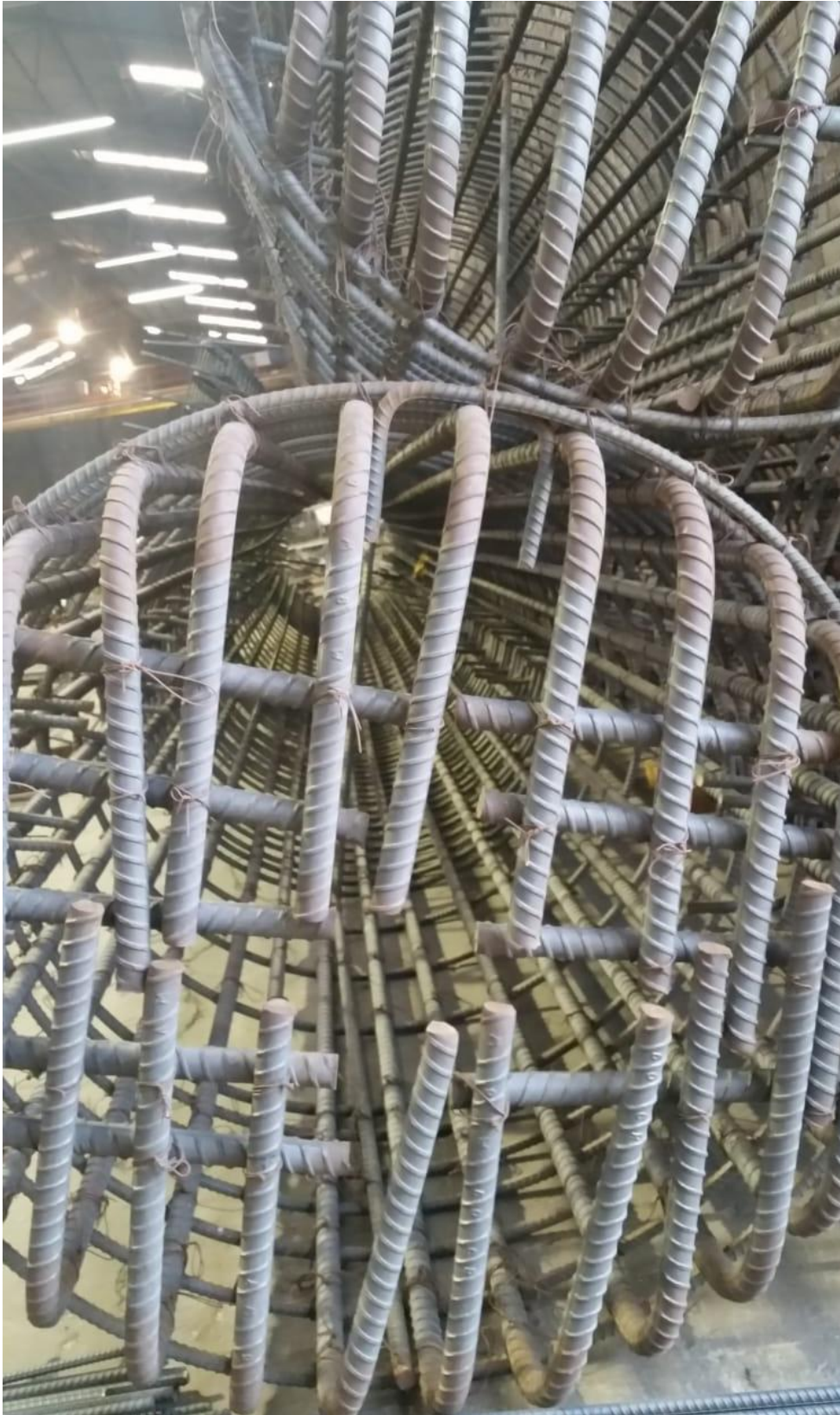
5.4.15 Imagen 15, Pilotes de CR, armado de pilotes, autoría propia
