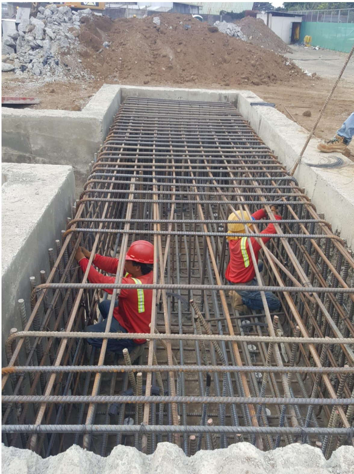
5.4.13 Imagen 13, Ampliación paso Firestone, armado de pedestal, autoría propia
