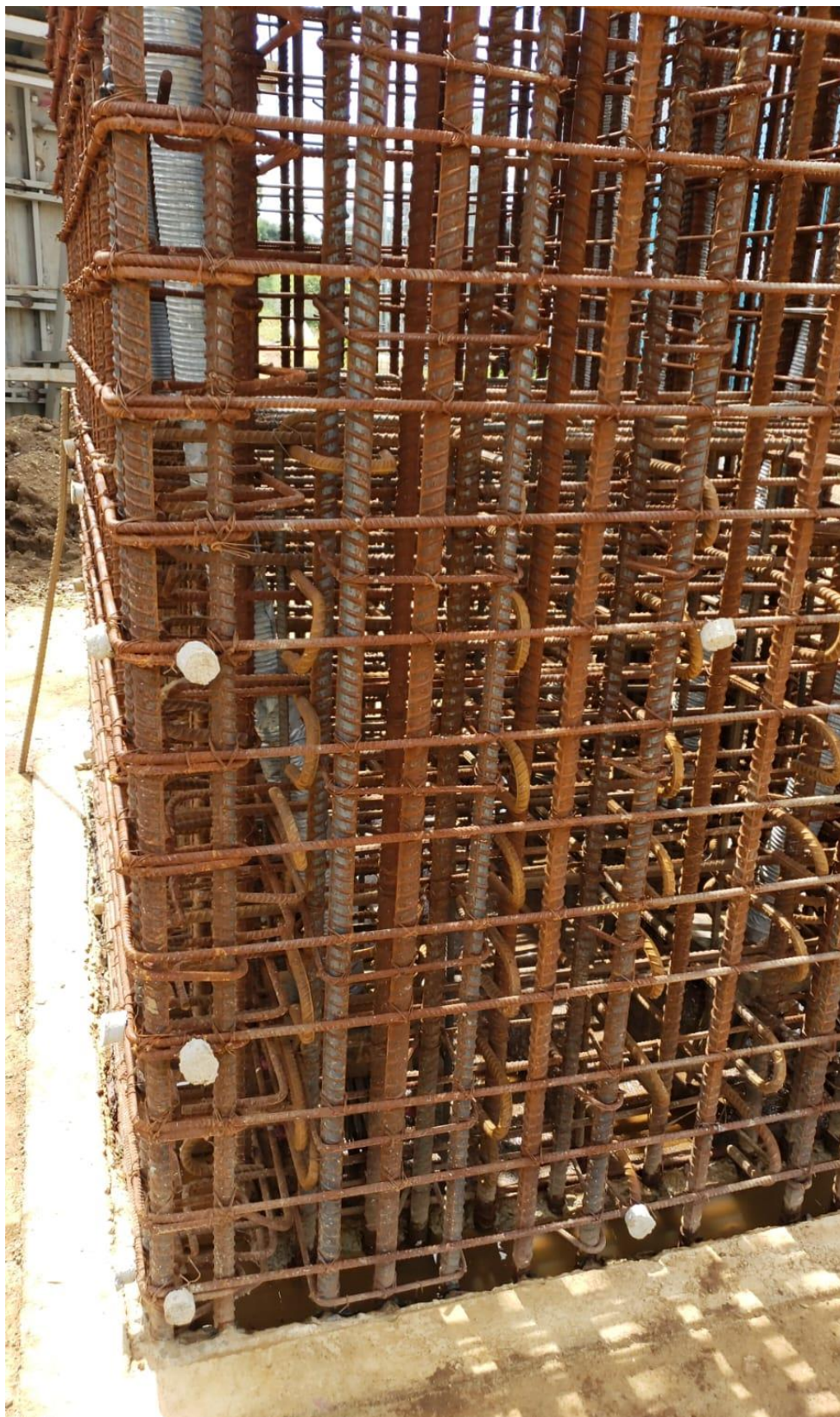
5.4.17 Imagen 17, Casa Hacienda Los Reyes, armado de columna, autoría propia
