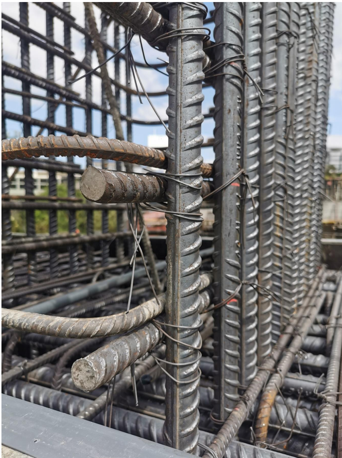
5.4.2 Imagen 2, Proyecto La Bandera, amarras en armadura, autoría propia
