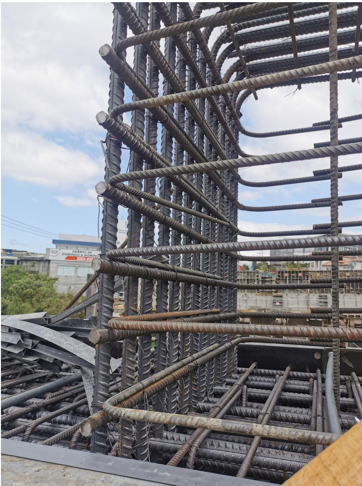
5.4.3 Imagen 3, Proyecto La Bandera, amarras en armadura, autoría propia
