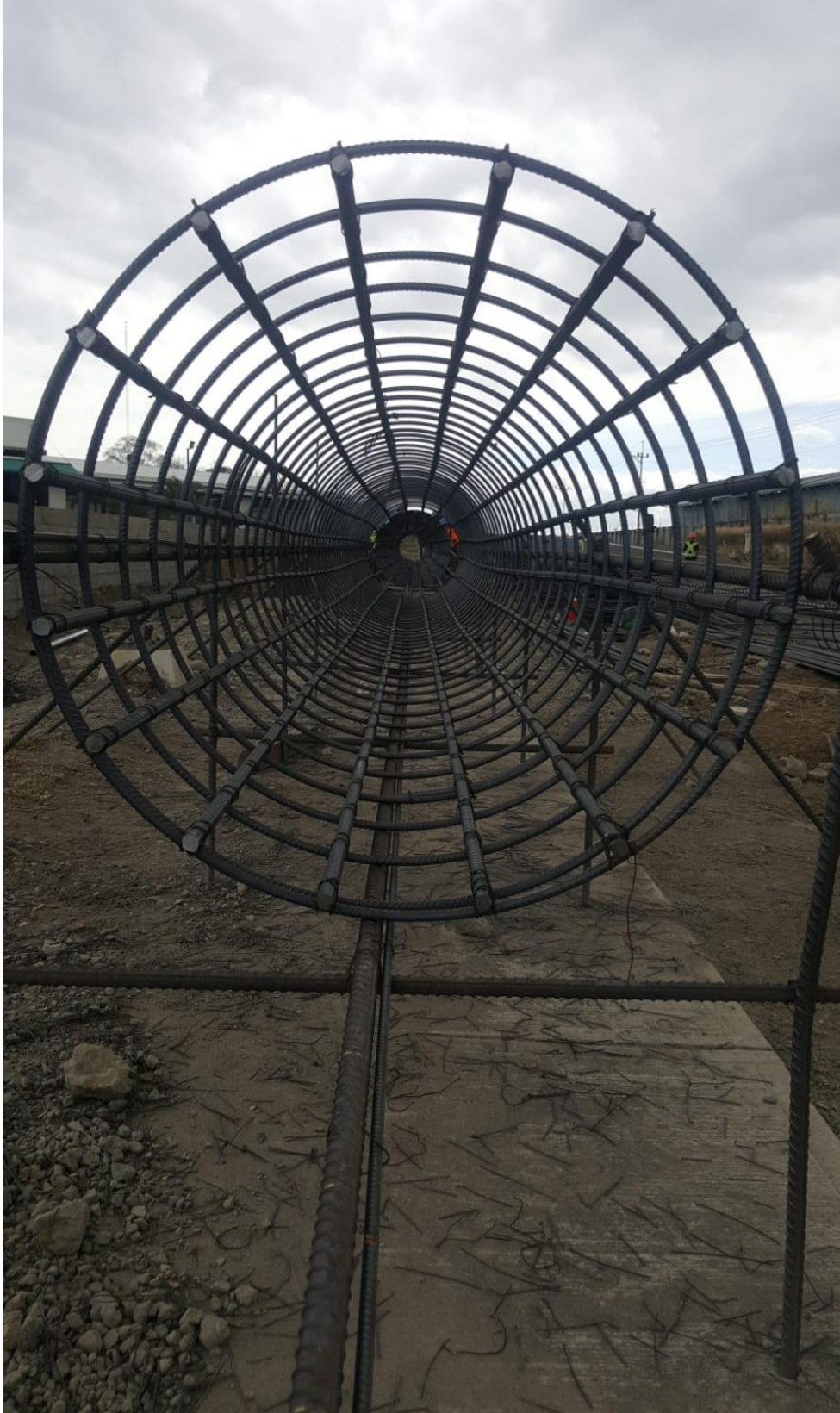
5.4.14 Imagen 14, Pilotes de CR, armado de pilotes, autoría propia
