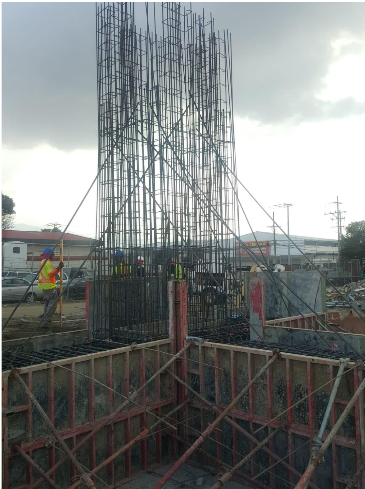
5.4.12 Imagen 12, Ampliación paso Firestone, armado de columna, autoría propia
