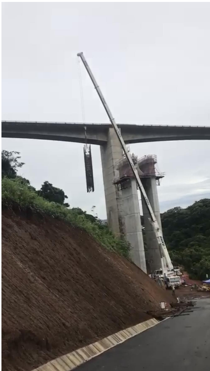
5.4.6 Imagen 6, Proyecto Puesto Saprissa, levantamiento de armaduras, autoría propia
