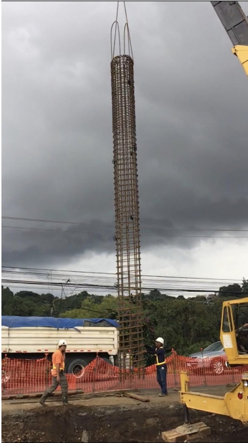
5.4.7 Imagen 7, Proyecto Paso a desnivel Guadalupe, levantamiento de armaduras, autoría propia
