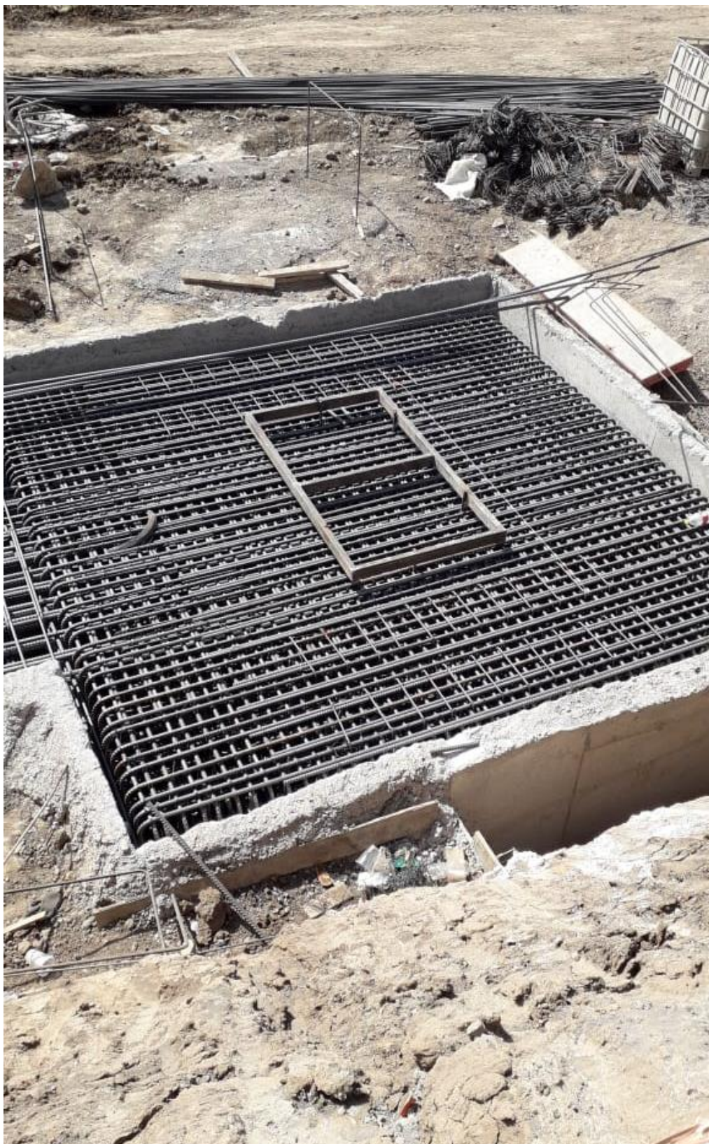
5.4.10 Imagen 10, Ampliación paso Firestone, losa de fundación, autoría propia
