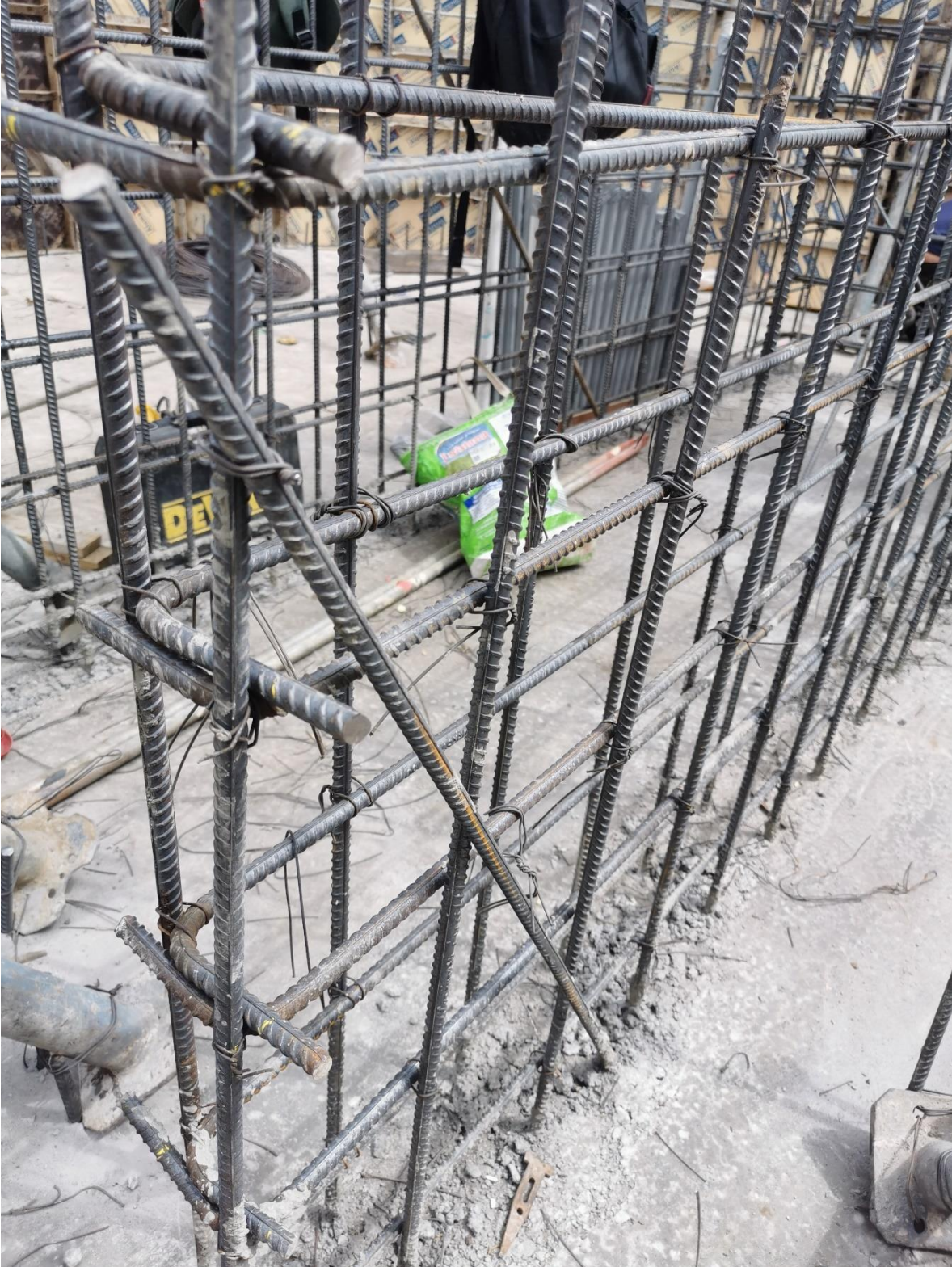
5.4.8 Imagen 8, Proyecto La Bandera, barra de apoyo para la armadura, autoría propia
