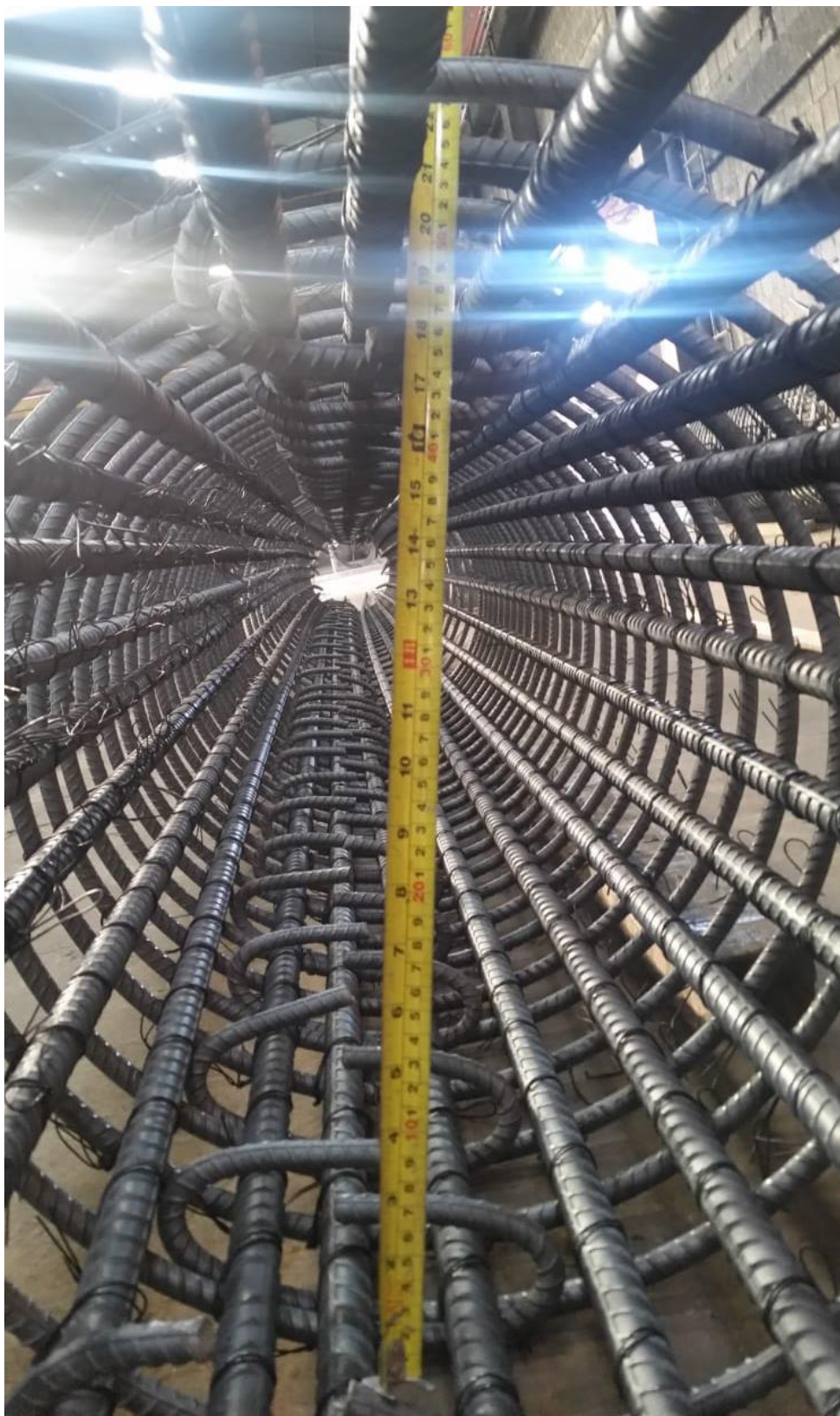
5.4.16 Imagen 16, Pilotes de CR, armado de pilotes, autoría propia
