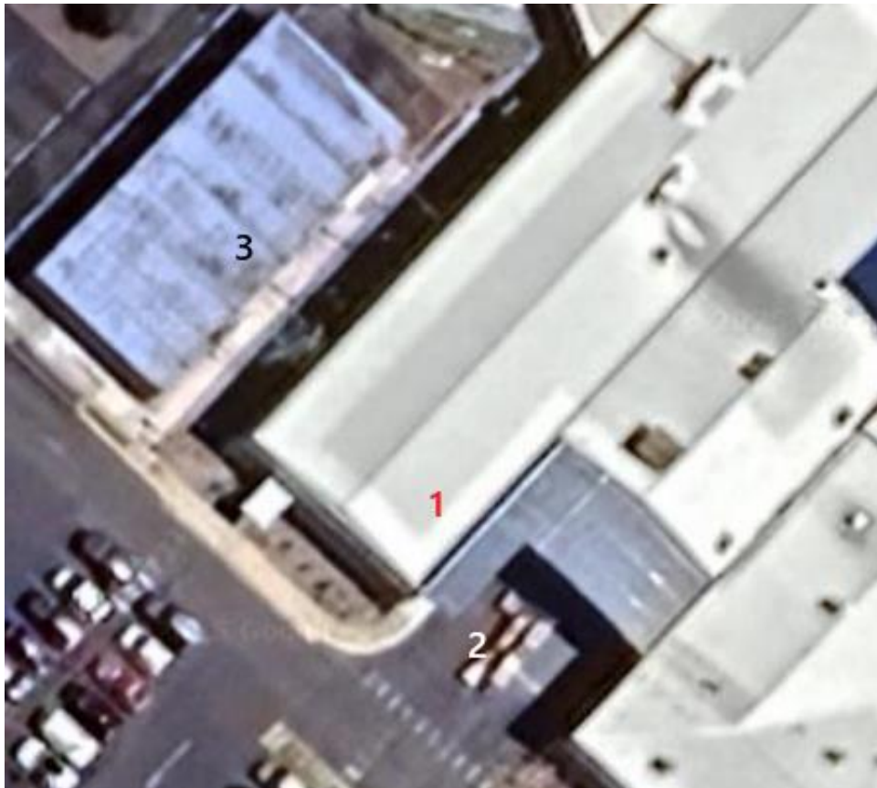
Figura 4.35: Vista superior de AGBS
