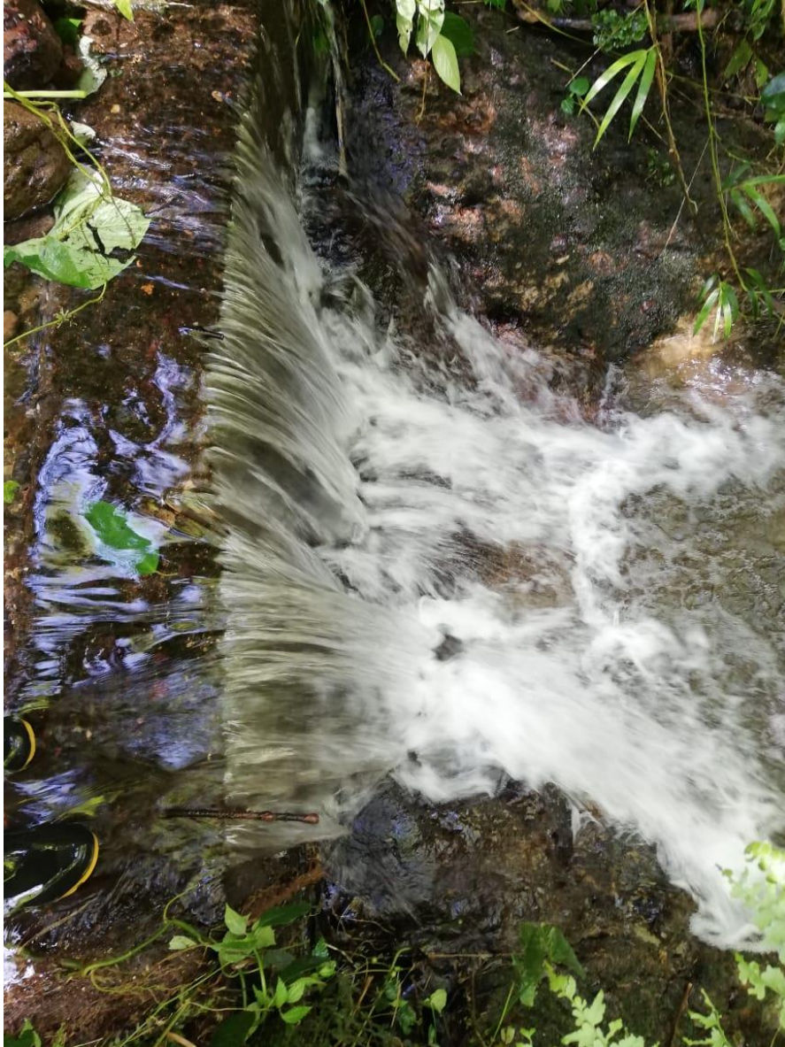
Figura 16. Represa existente en Quebrada Grande sin funcionamiento
