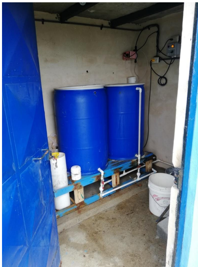
Figura 7. Sistema de cloración
