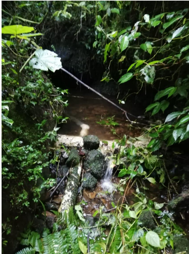
Figura 13. Captación de agua existente para abastecer una finca situada en la naciente
