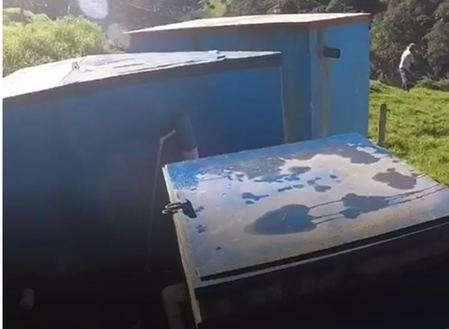
Figura 5. Desarenadores ASADA de Cascajal
