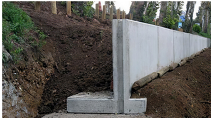
Ilustración 47. Muro de contención
