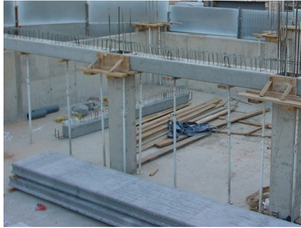
Ilustración 46. Viga de concreto armado
