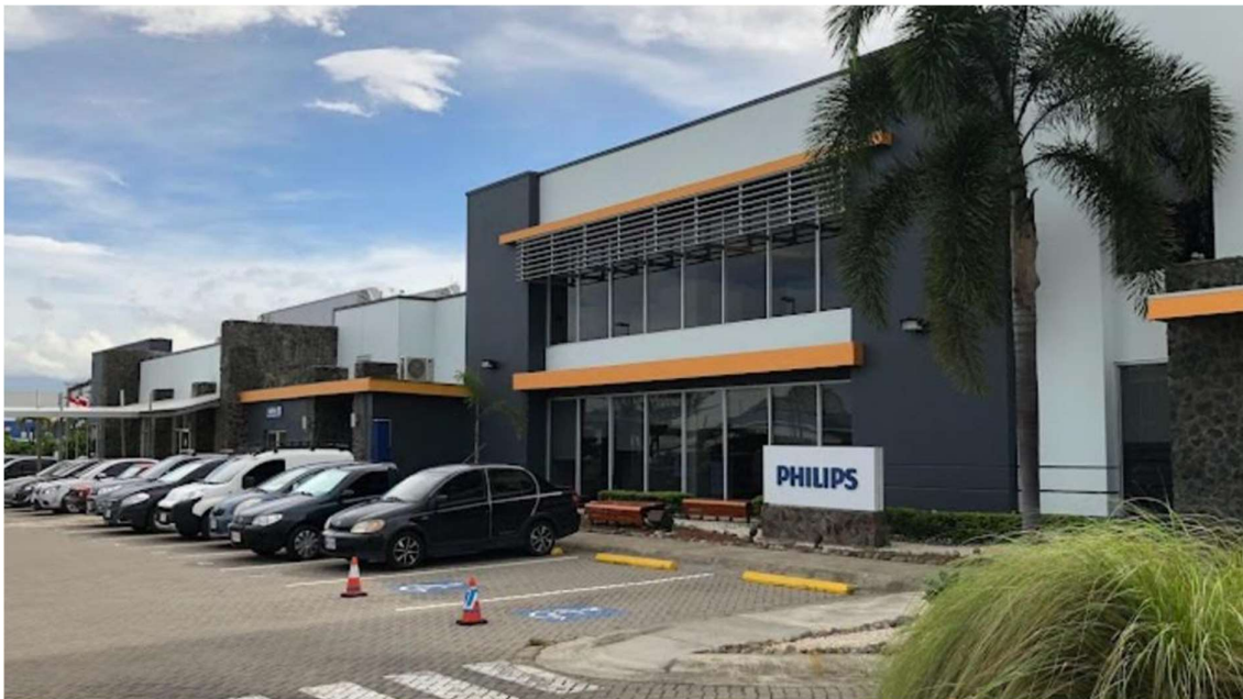
Figura 3. Edificio, Philips Costa Rica
