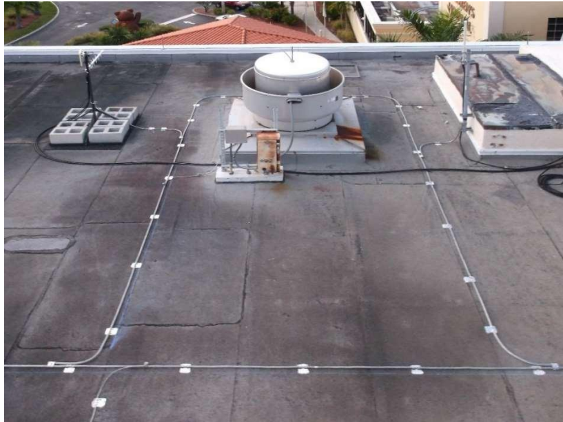
Figura 2.10 Ejemplo de interconexión de conductores
