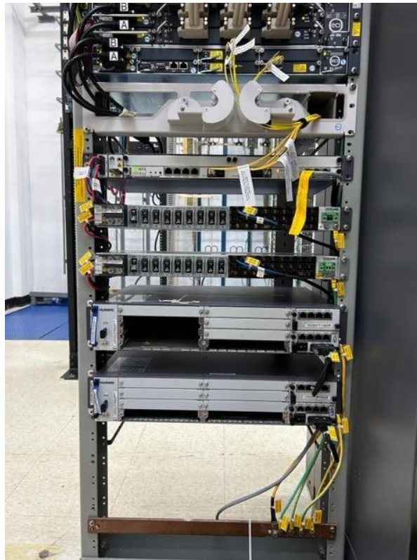
Figura 28 Trabajos instalación módulos en nueva posición
