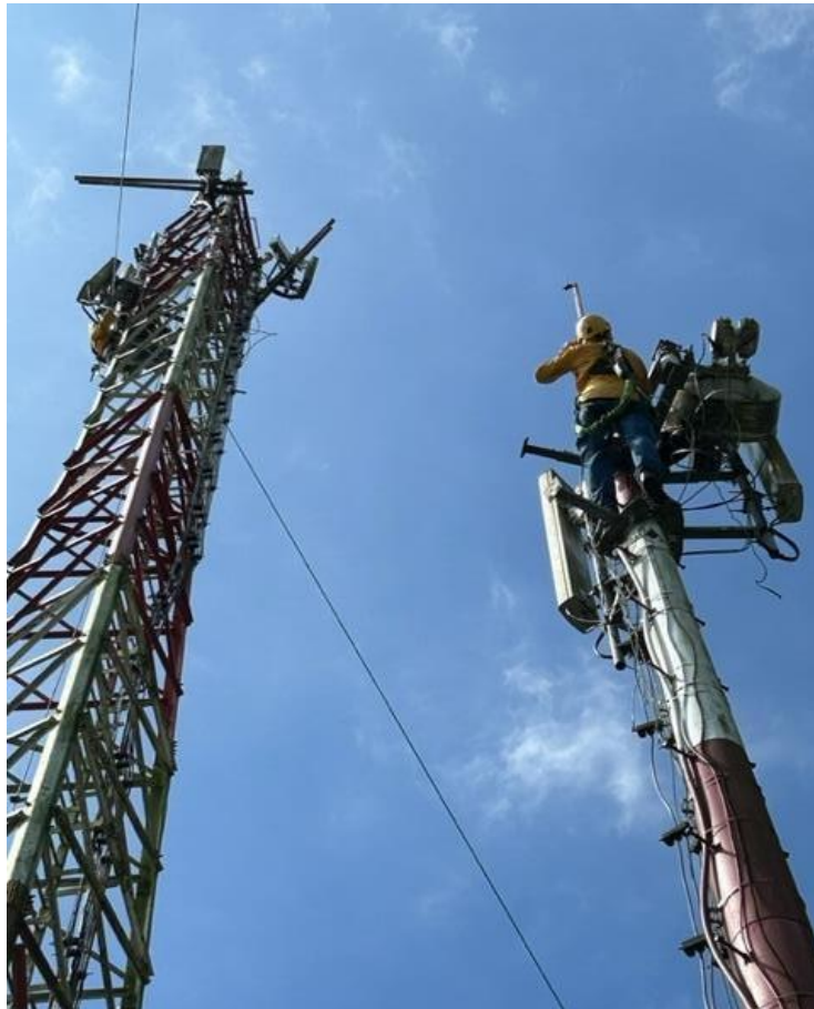
Figura 33 Trabajos de traslado de sistemas radiantes
