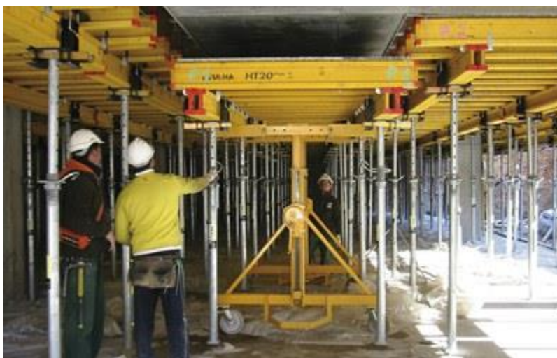
Figura 16. Encofrado tipo mesas. Fuente: Universidad Politécnica de Valencia
