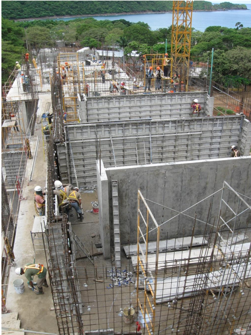
Figura 15. Formaleta Forsa. Edificio T Hotel DREAMS LAS MAREAS. Fuente: Volio & Trejos.
