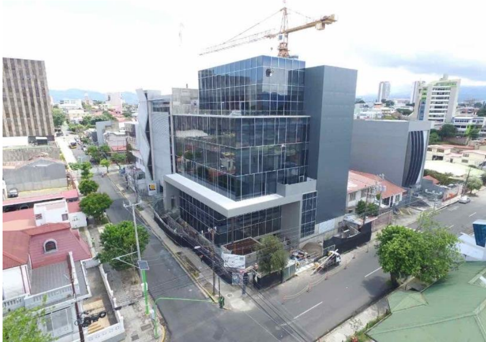
Figura 36. Edificios JUPEMA. Fuente Volio & Trejos
