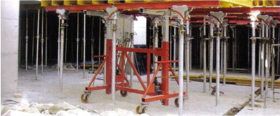
Figura 17. Encofrado tipo mesas. Fuente: Universidad Politécnica de Valencia
