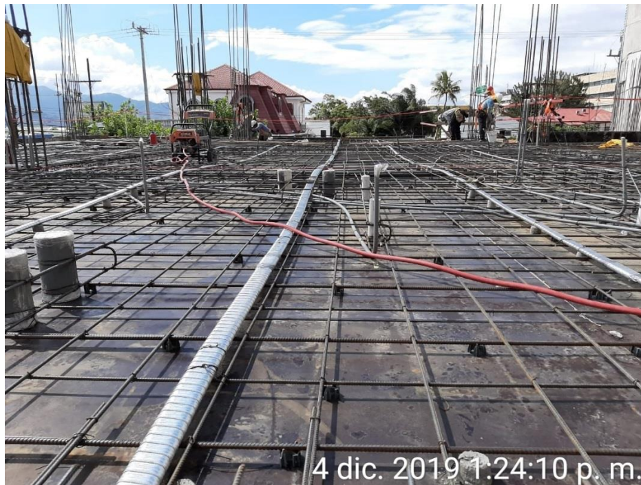
Figura 19. Entrepiso postensado Proyecto JUPEMA. Fuente: Volio & Trejos
