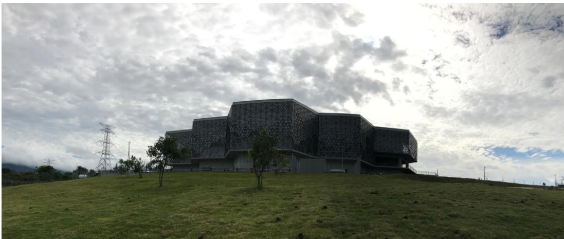
Figura 33. Centro Nacional de Control de Energía. Fuente Volio & Trejos
