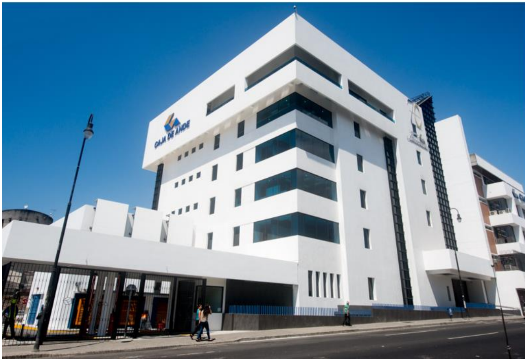
Figura 29. Edificio Caja Ande San José. Fuente Volio & Trejos
