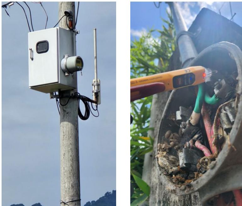
Figura 5.1: Colector y base del medidor junto con los bloques terminales
