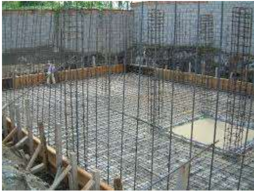
Figura 10. Tanque de Mampostería. Prodisi
