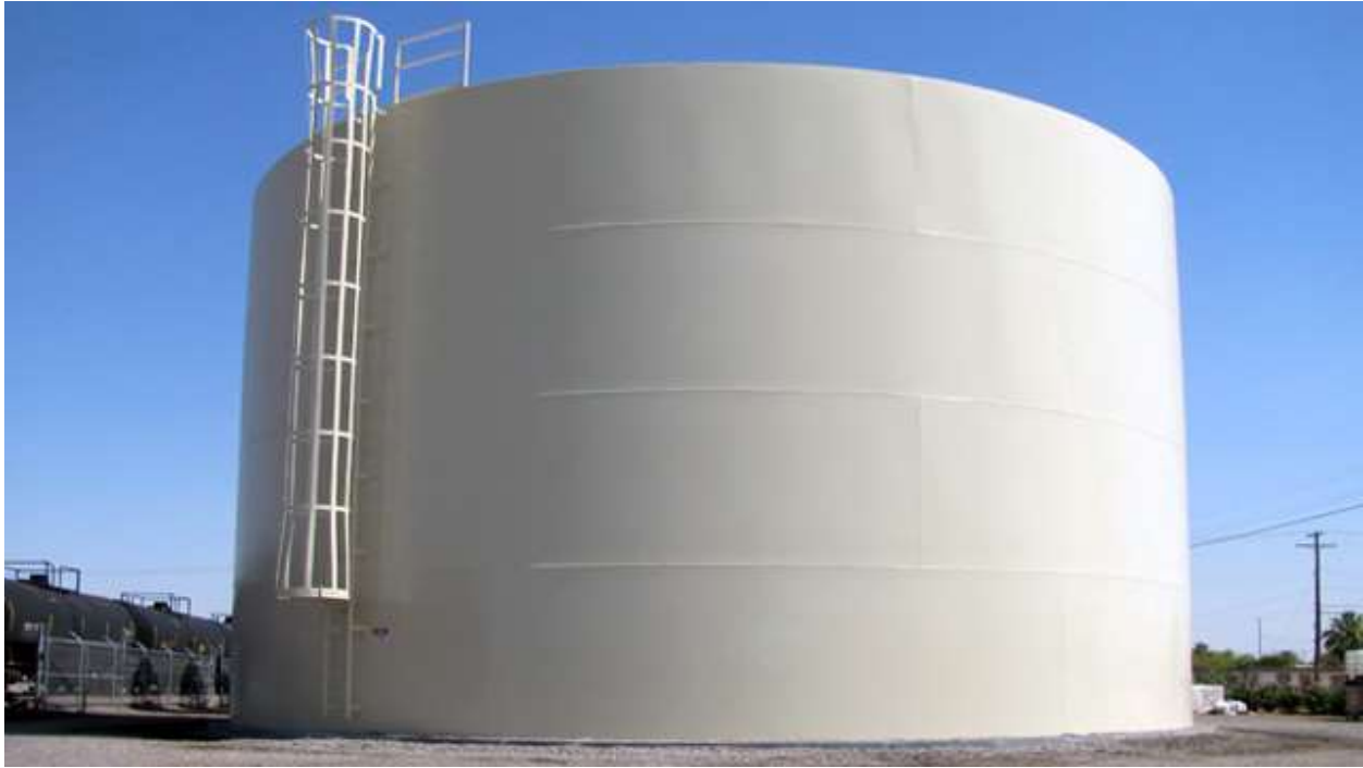
Figura 7. Tanque de Acero, Superior Tank Co. Inc.
