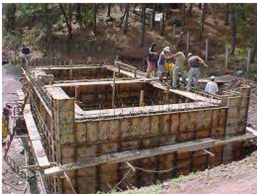
Figura 9. Tanque de Concreto Armado, Industrias Bendig
