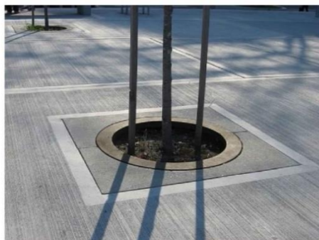
D CONCRETO ESCOBILLADO
