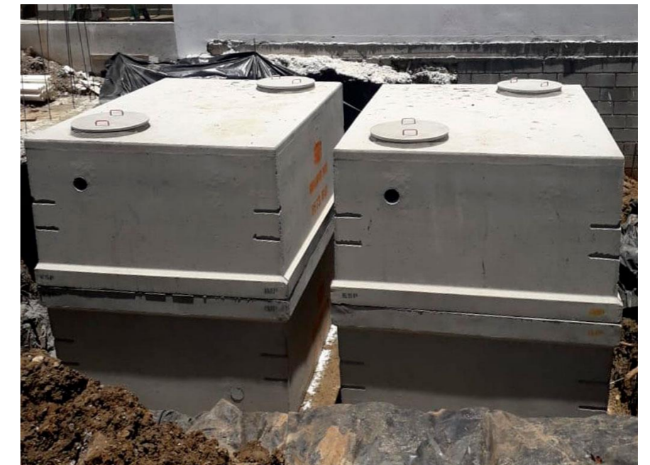
Instalación tanques Agua Potable
