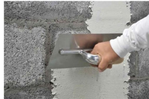
PAREDES DE BLOQUES REPELLADAS PULIDAS Y PINTADAS
