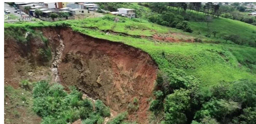
Deslizamiento urbanización Valladolid
