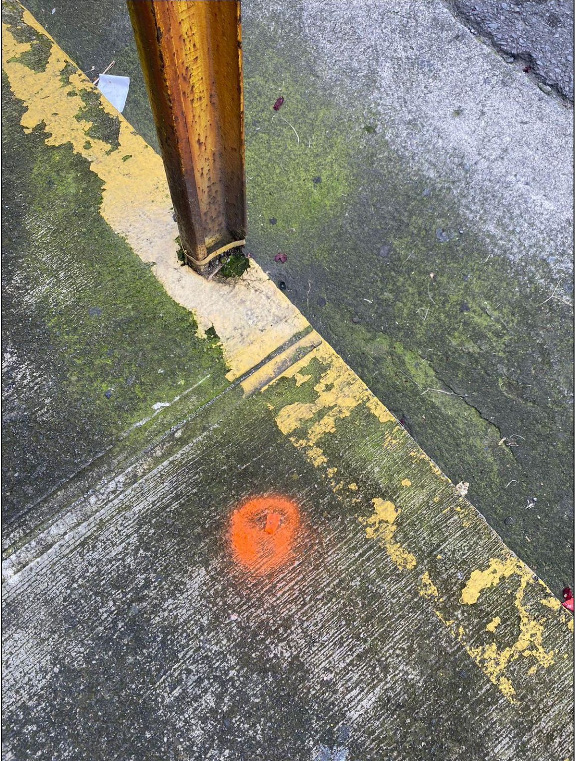
Figura 17. Vista frontal del punto 2 Fuente: Elaboración propia
