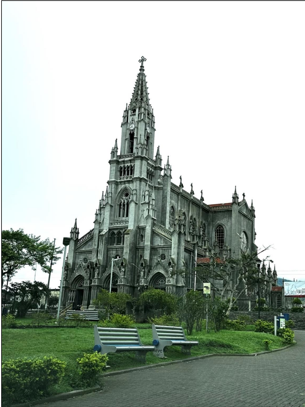
Figura 10. Estado de la acera en sector oeste a la iglesia Fuente: Elaboración propia
