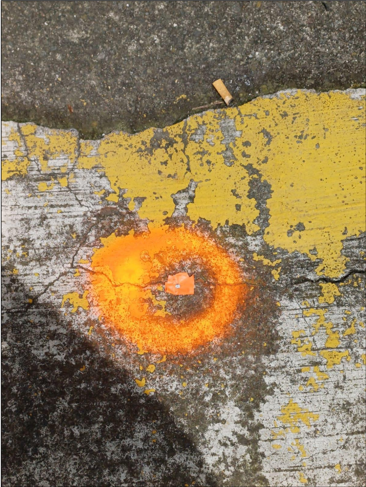
Figura 15. Vista frontal del punto 1 Fuente: Elaboración propia
