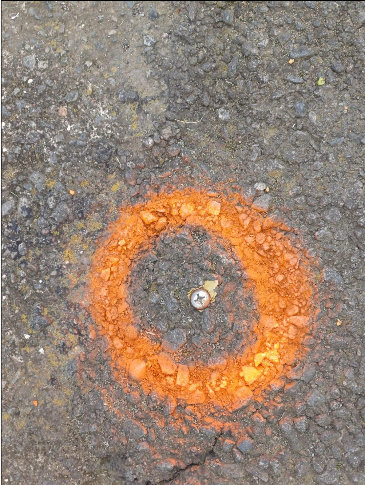
Figura 21. Vista frontal del punto 4 Fuente: Elaboración propia
