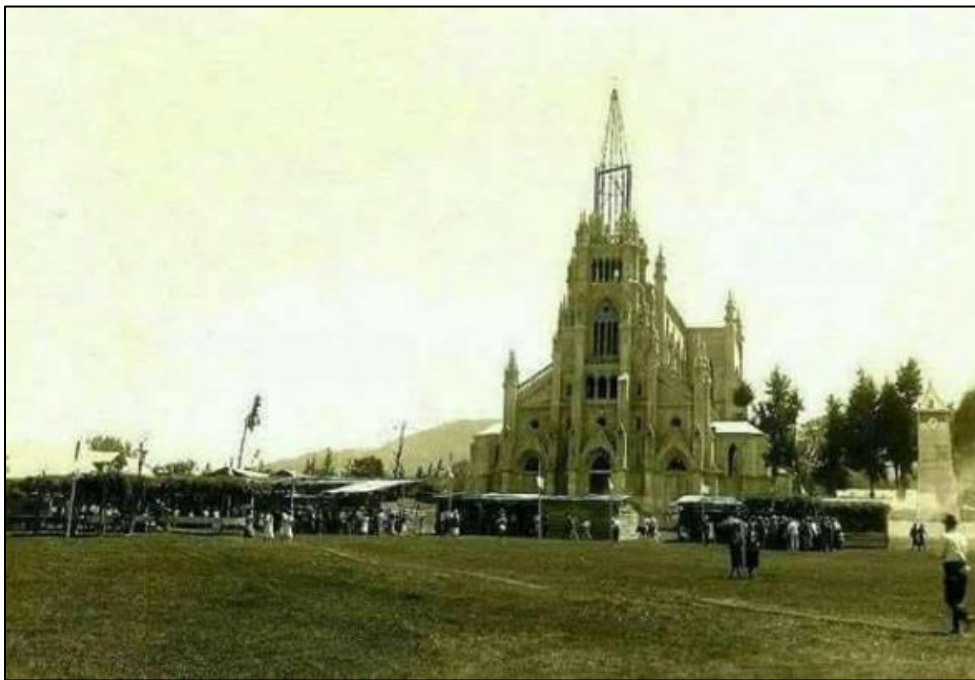
Figura 3. Templo en construcción Fuente: Castillo, 2017
