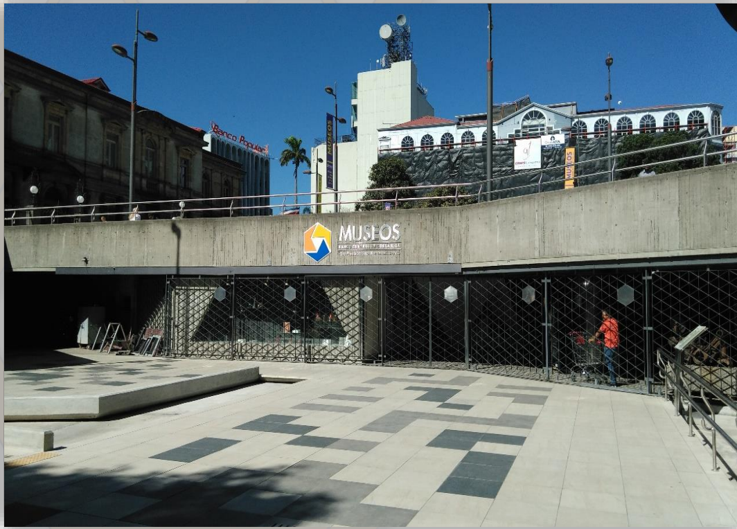
Imagen 10. Fachada del Museo del Banco Central de CR. Fuente: Propia
