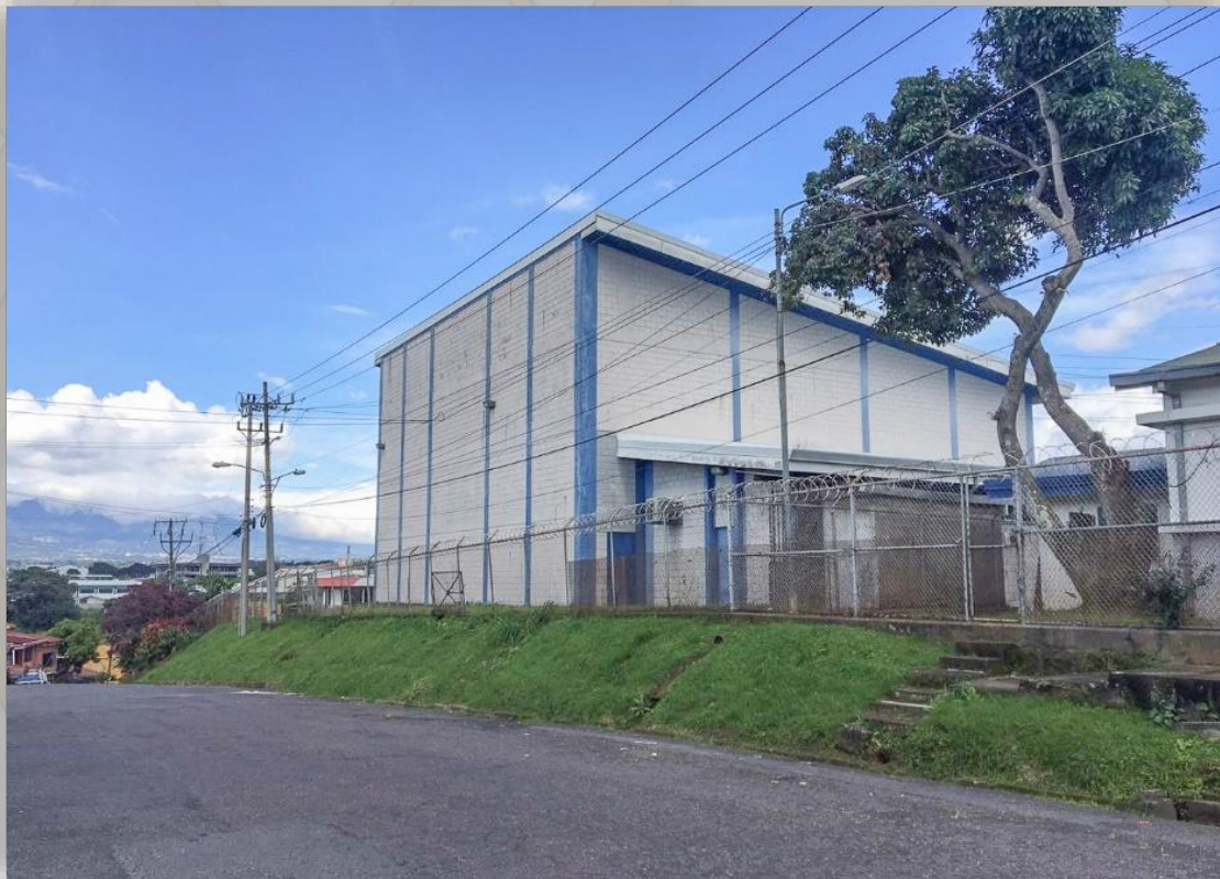
Imagen 43. Vista de edificio existente de ICE dentro de instalaciones de subestación de CNFL Uruca, calle Diagonal 39. Fuente: elaboración propia
