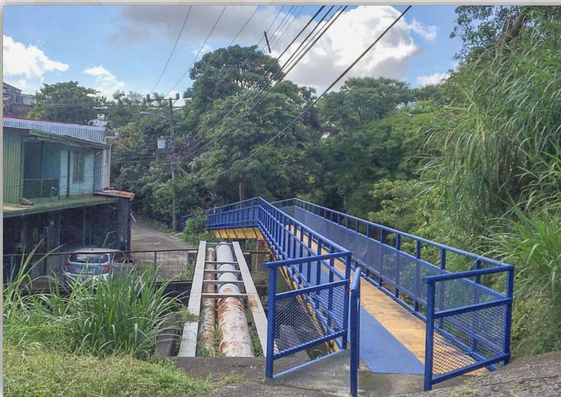
Imagen 45. Vista de puente peatonal sobre calle Diagonal 39. Se observan viviendas en la línea de vía sin aceras. Fuente: elaboración propia
