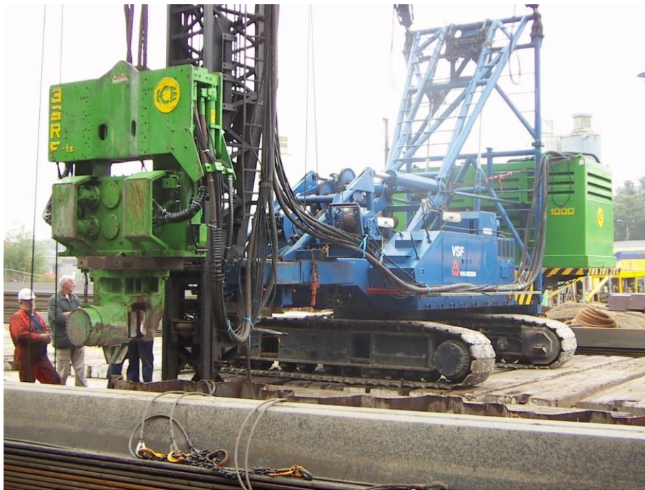
Ilustración 24. Grúa autopropulsada en sitio de construcción ( Nanjing Grand Steel Piling , 2020).
