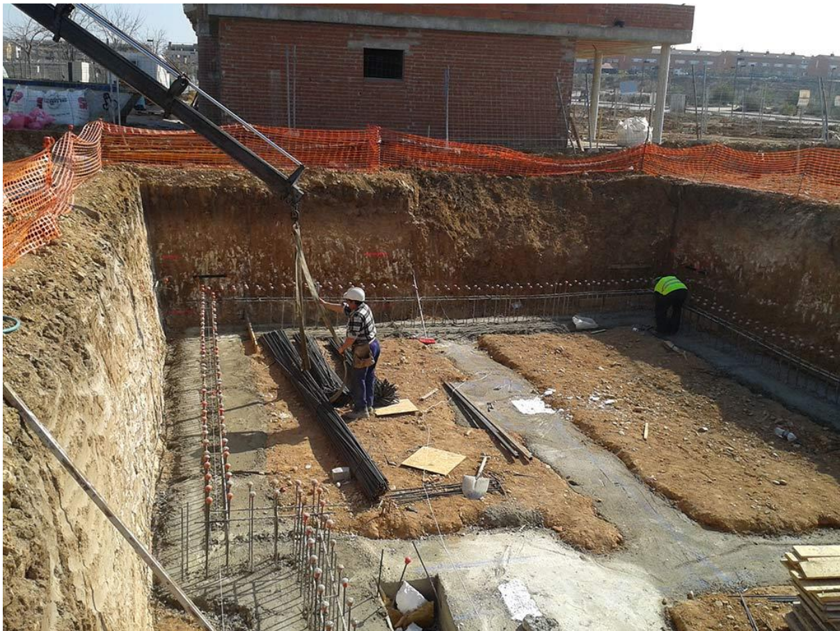
Ilustración 5. Excavación estructural (Moscozo, 2011).
