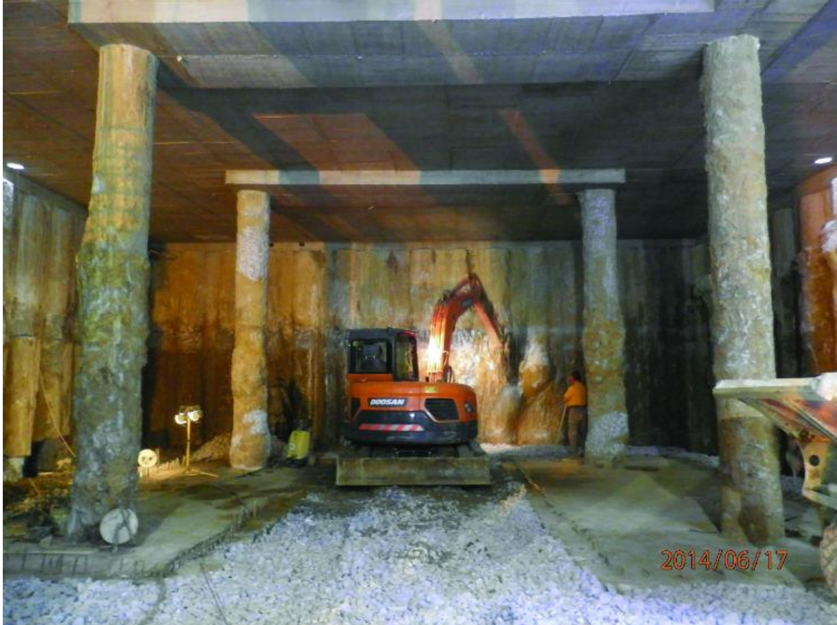
Ilustración 2. Excavación de subnivel utilizando el sistema Top-Down (Payer, 2014).
