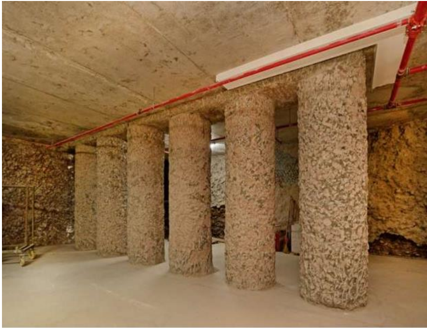
Ilustración 1. Sótano construido con el sistema Top-Down con tablestaca en Perú.
