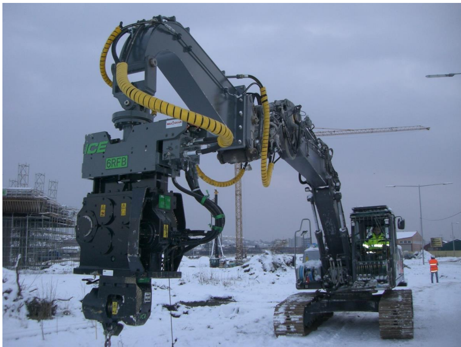
Ilustración 26. Excavadora con vibrohincador ( TIEFBAUTECHNIK , 2020).
