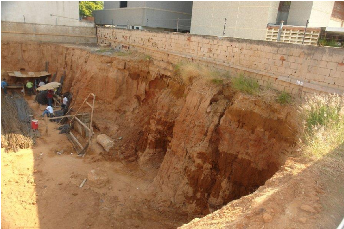
Ilustración 4. Excavación masiva de sótano ( Moscozo, 2011 ).
