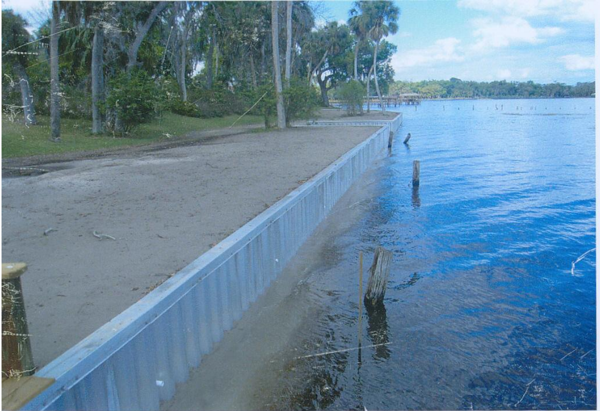
Ilustración 10. Muro de tablestaca de aluminio en contención de erosión del terreno en límite marítimo terrestre.
