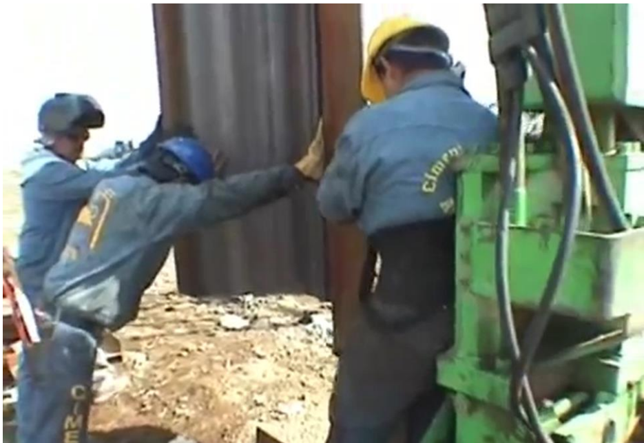
Ilustración 27. Alineamiento de la tablestaca ( Shunli Steel Group , 2015).
