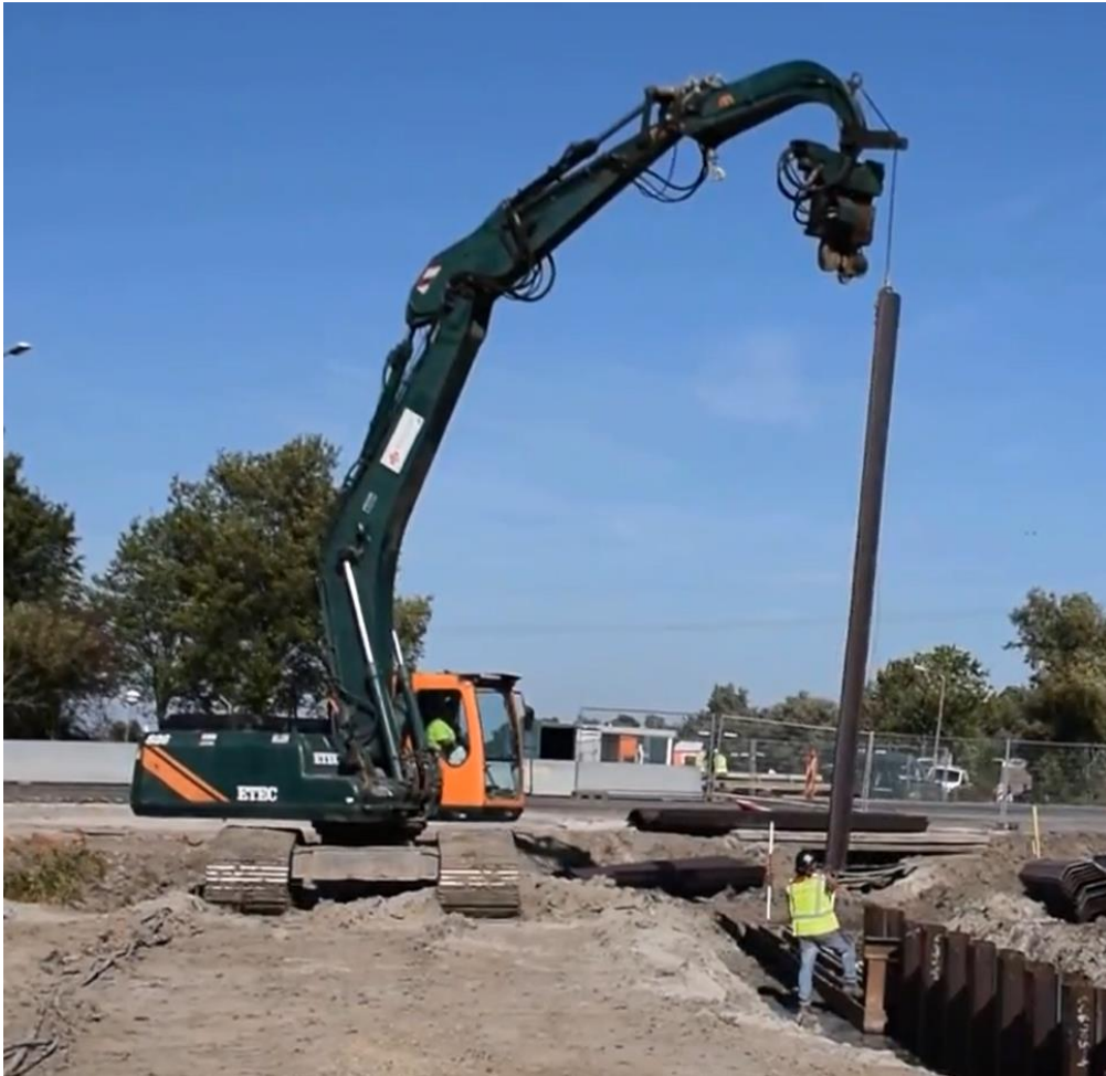
Ilustración 28. Colocación de tablestaca ( Heavy Construction Equipment Channel ).
