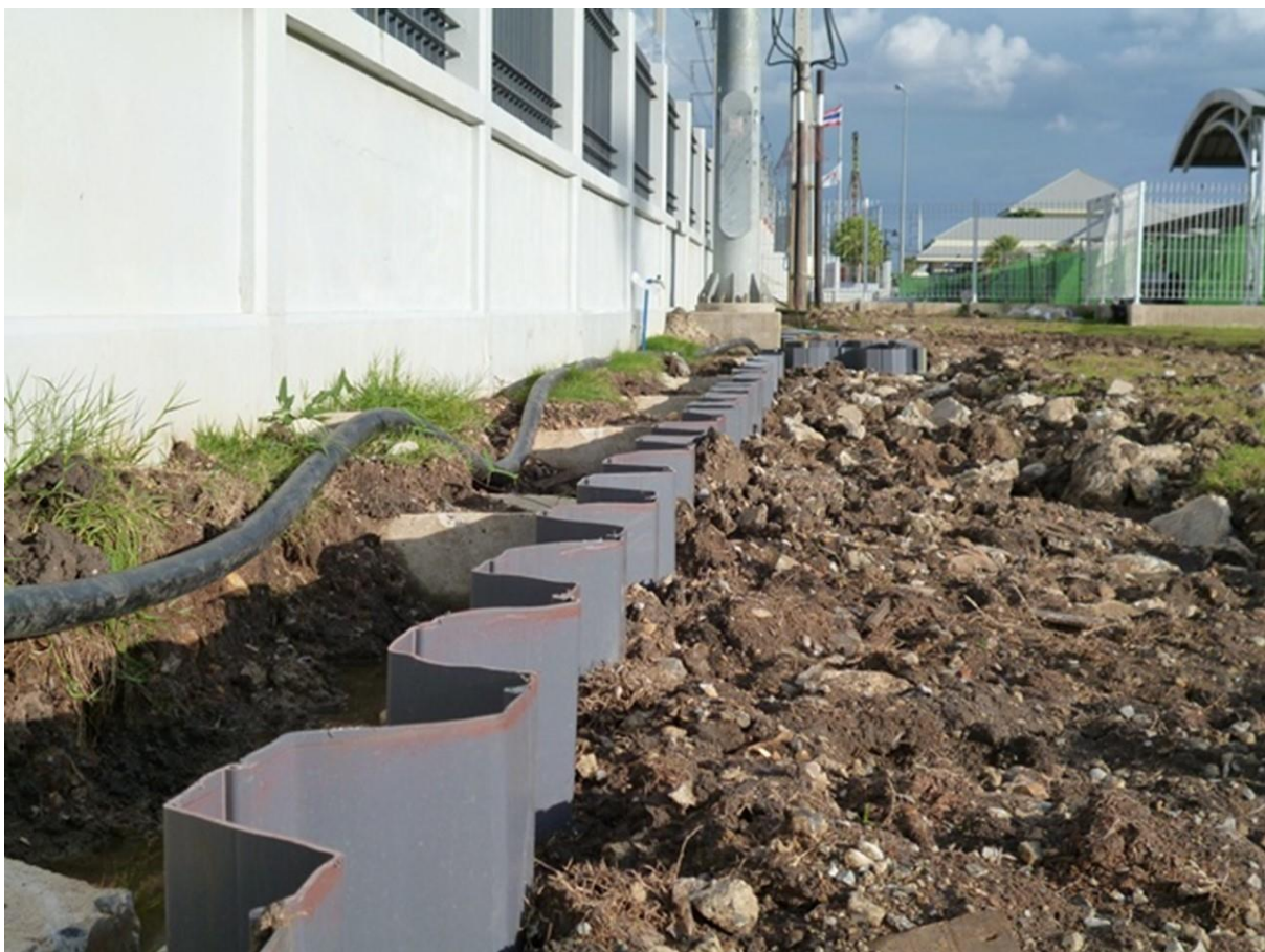
Ilustración 14. Tablestaca hincada en el suelo al 90% de su altura (CETEAU, 2020).
