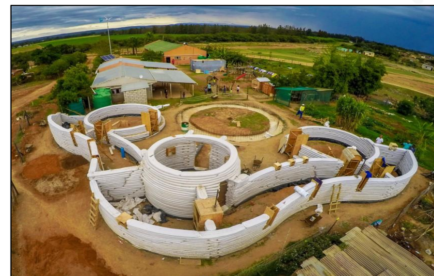
Figura 17. Proceso constructivo, Centro Infantil Langbos. Fuente: Grava Chris (2018).
